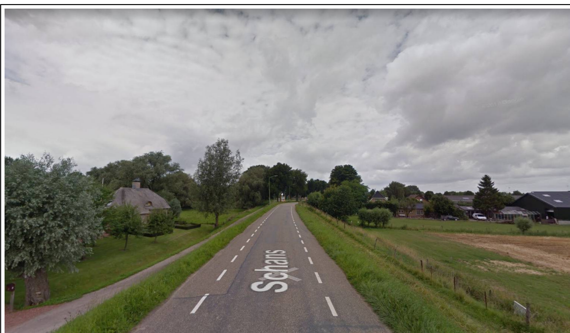
Figuur 7 – Huidige situatie weg de Schans (bron: Google Streetview)
