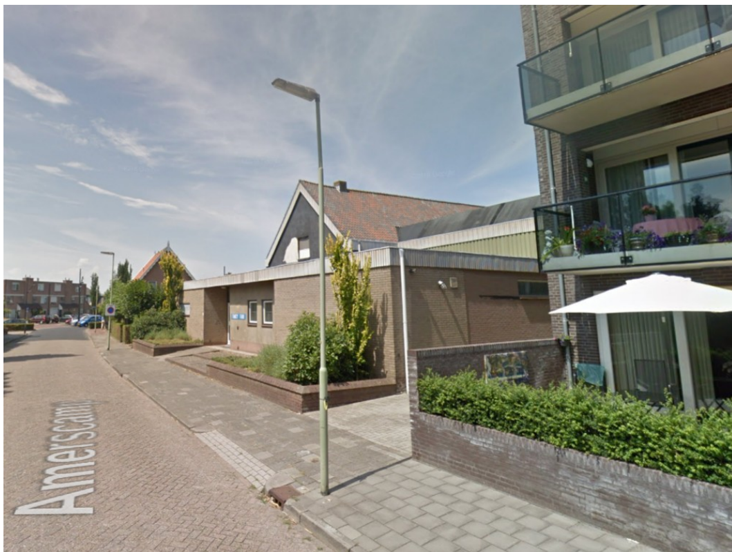
Figuur 13: Het plangebied gezien vanaf Amerscamp in noordwestelijke richting (Google Maps Street View, juli 2018).
