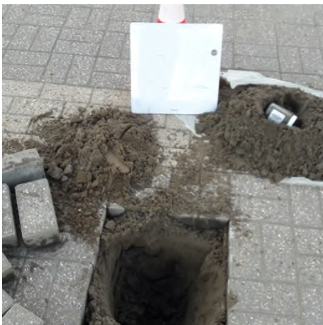
Fotonummer: 11 Omschrijving: Boring 011.
