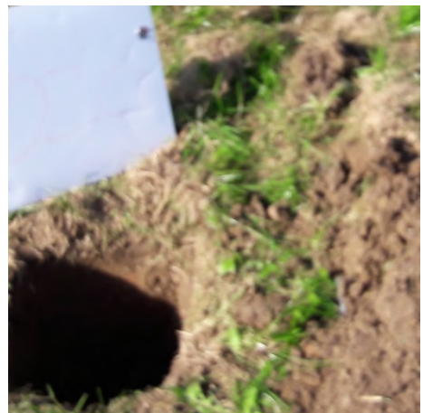
Fotonummer: 12 Omschrijving: Boring 020.
