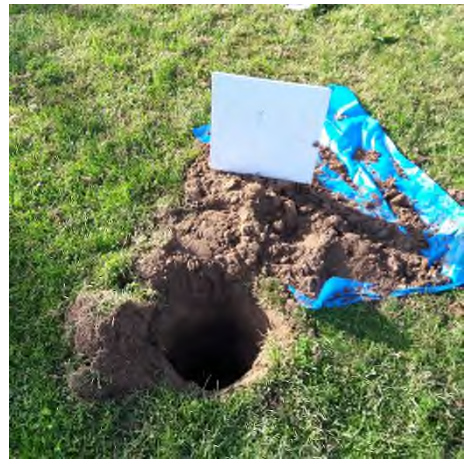
Fotonummer: 22 Omschrijving: Boring 017.
