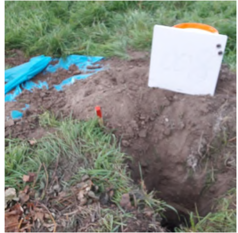
Fotonummer: 8 Omschrijving: Boring 008.
