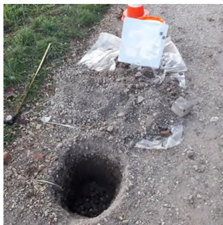
Fotonummer: 4 Omschrijving: Boring 004.
