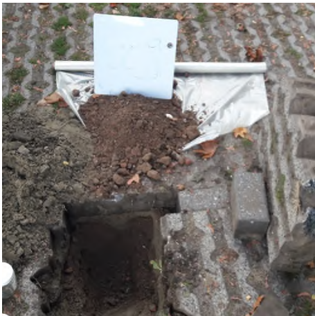
Fotonummer: 9 Omschrijving: Boring 009.
