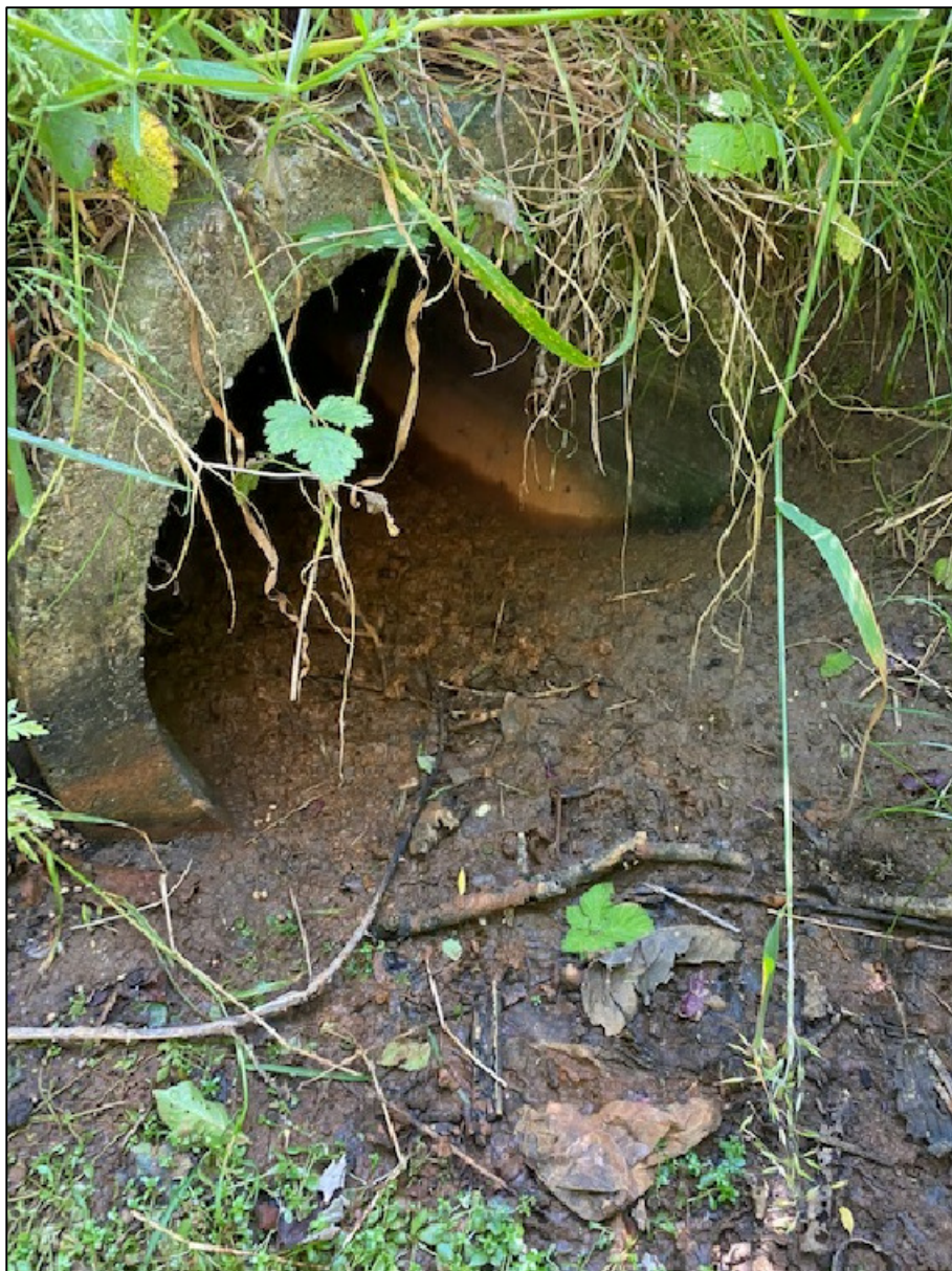
FOTO 10: bestaande buis rond 600mm tbv waterafvoer westzijde plangebied
