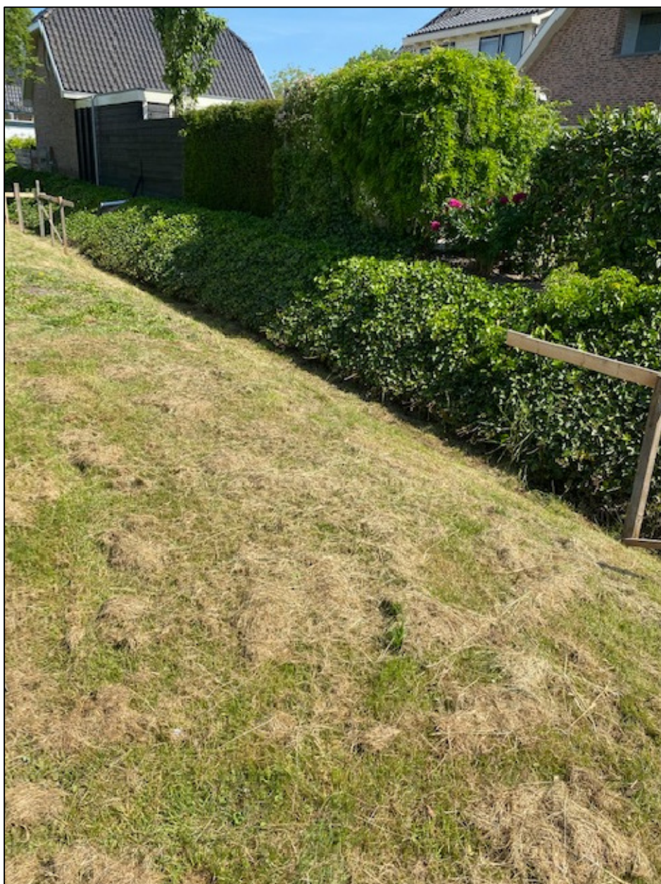
FOTO 8: bestaande watergang aan de westzijde. Deze valt buiten de beschermde zone.
