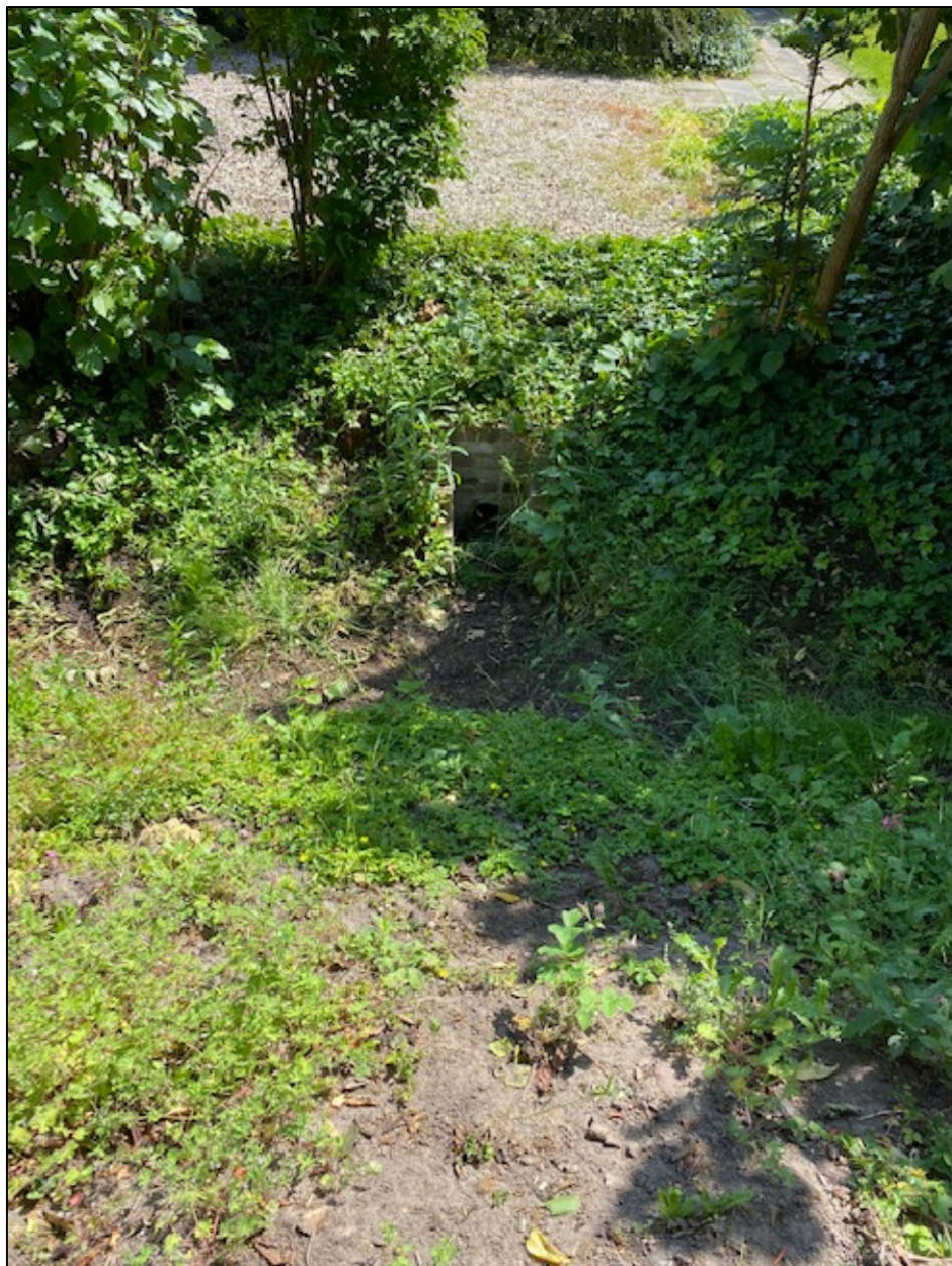
FOTO 11: bestaande afvoer woonhuis oostzijde
