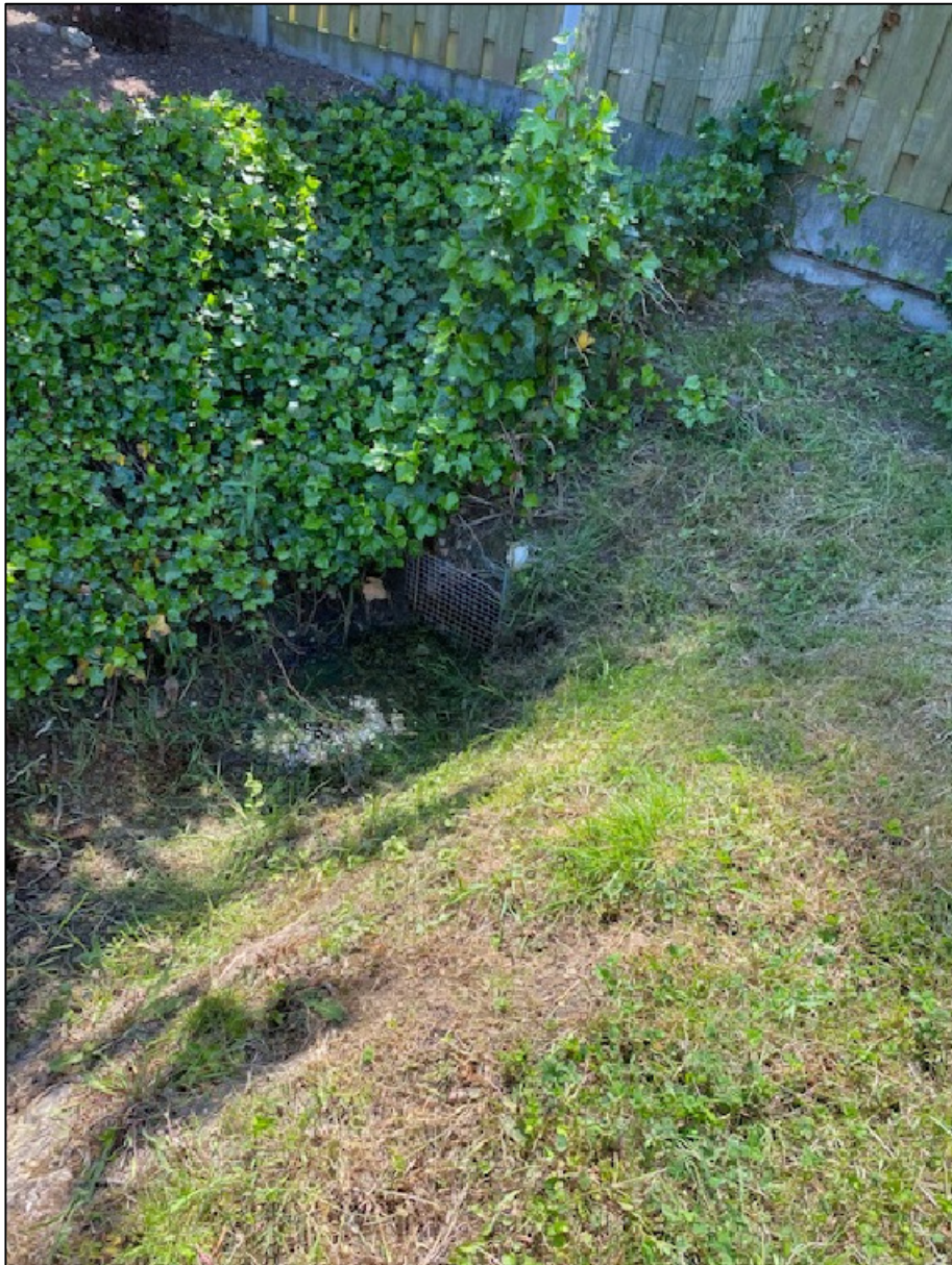
FOTO 9: bestaande buis rond 600mm tbv waterafvoer westzijde plangebied
