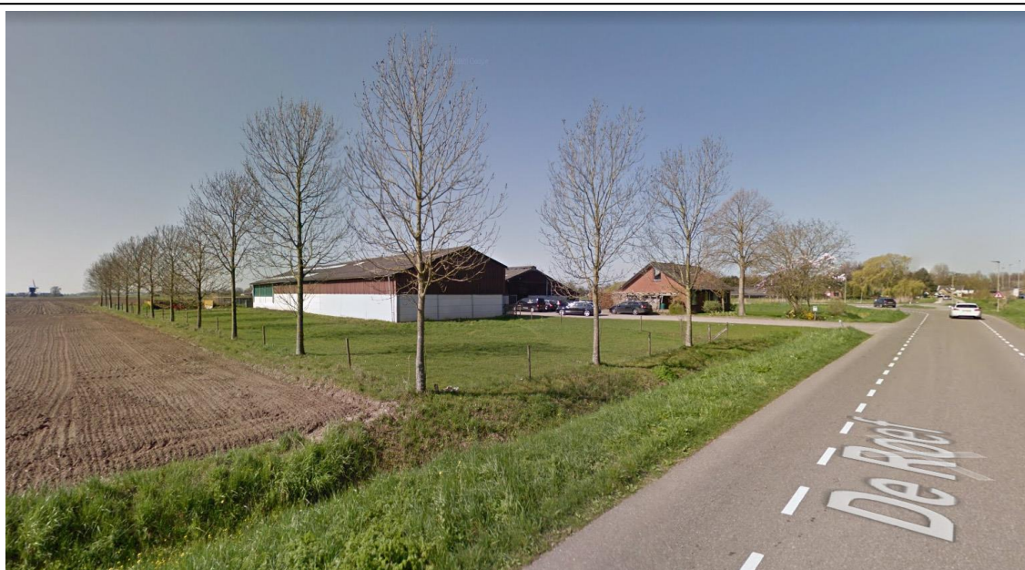
Figuur 12 – Huidige situatie deelgebied 1 (perceel De Roef 5), gezien vanaf het noordoosten (bron: Google Streetview)
