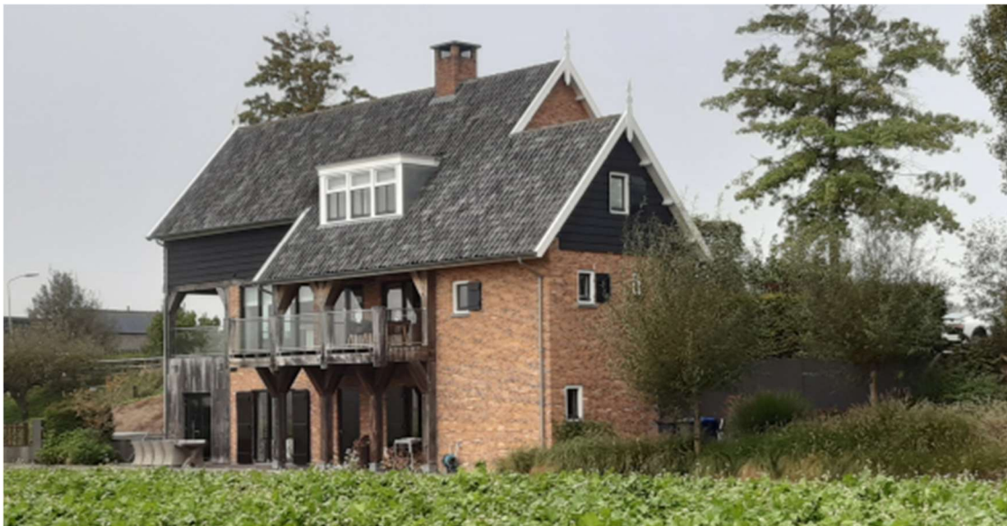
Afbeelding 12: Nieuwe woning Buitendijk 21
