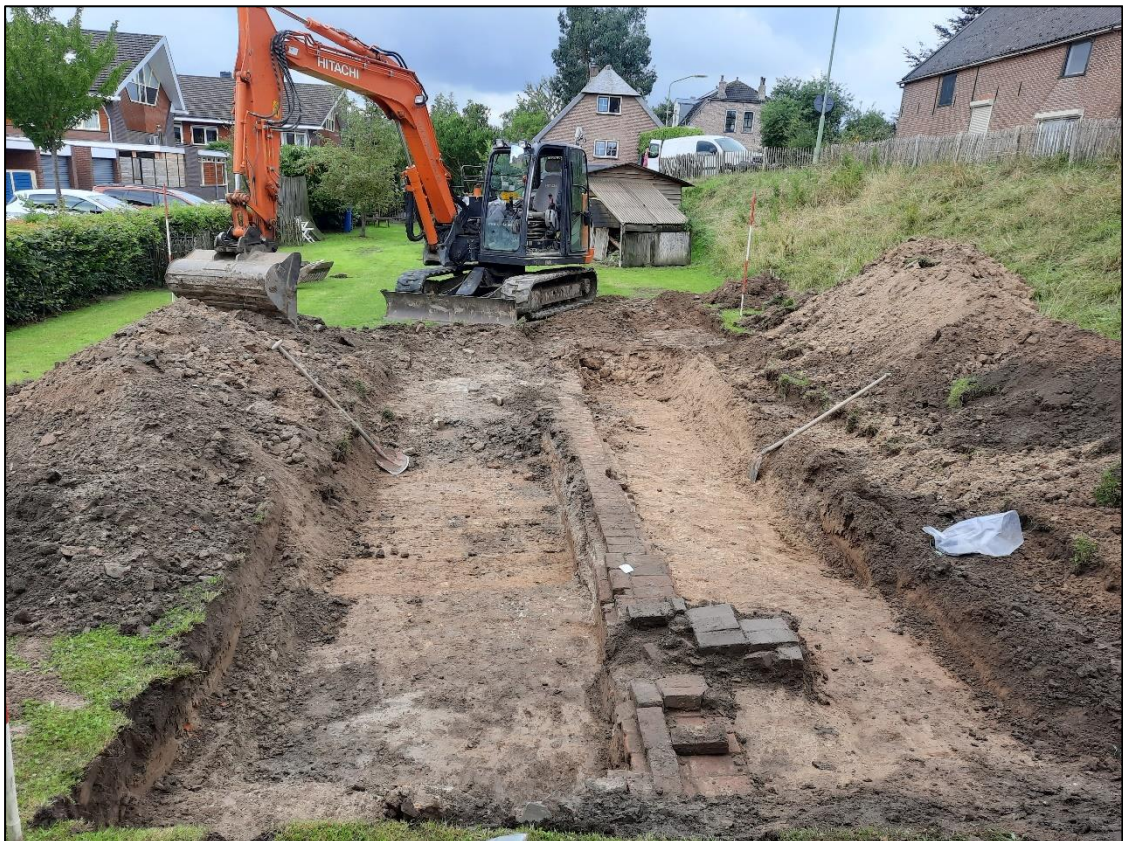
Figuur 3. Foto van de werkzaamheden in werkput 1.
