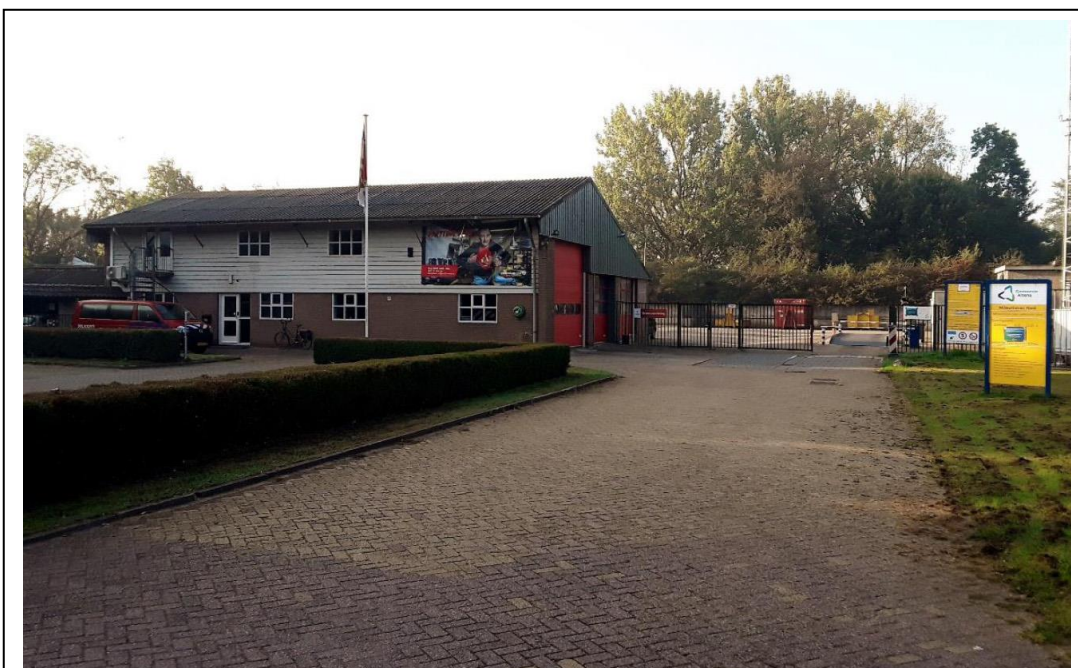
Figuur 6 – Bestaande situatie brandweerkazerne aan de Stadhoudershoeft 12 in Hank, ter hoogte van de bestaande in- en uitrit op de Stadhoudershoeft (bron: Ecologische quickscan, Maasarend)
