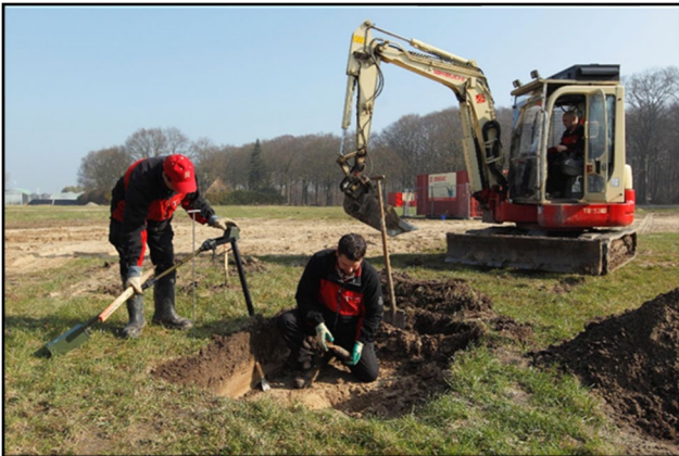
Figuur 9. Benaderen van een significant object m.b.v. een hydraulische graafmachine.
