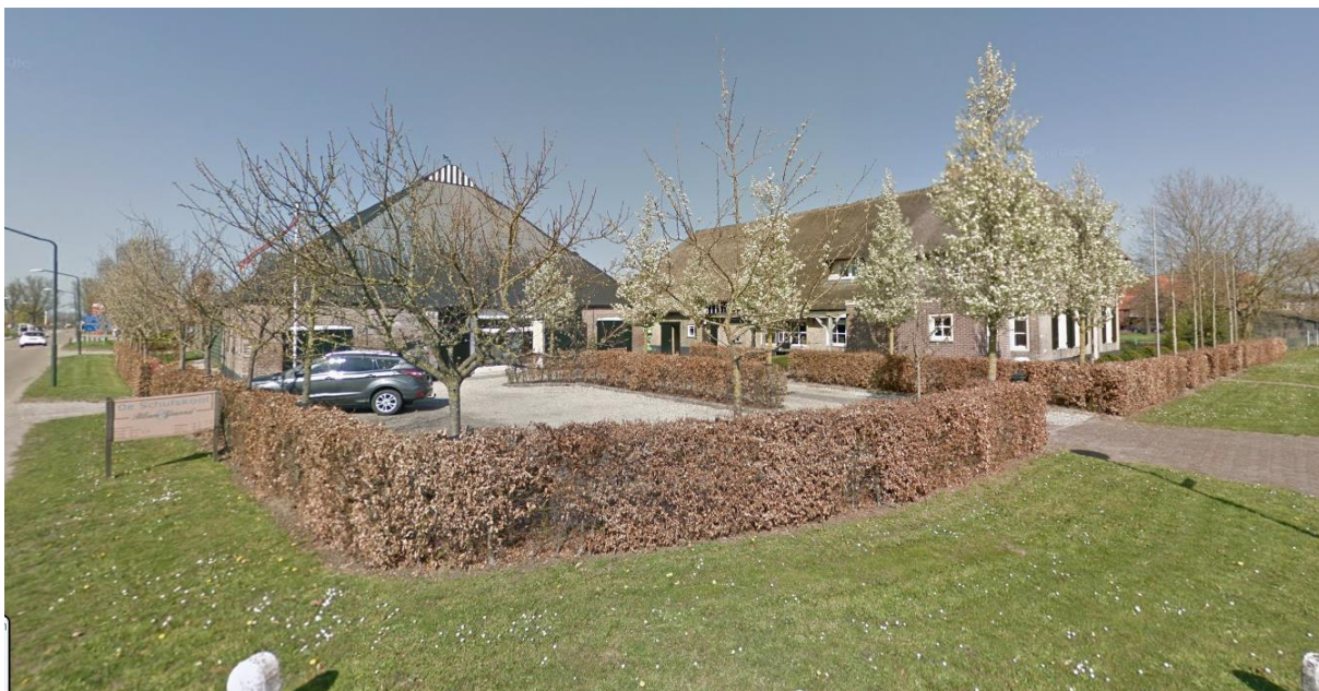
Figuur 8 Voorzijde van de monumentale boerderij met bestaande landschapselementen
