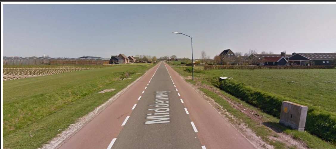
Figuur 9 – Bestaande situatie Middenweg (bron: Google Streetview)
