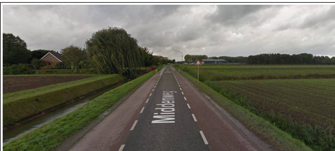
Figuur 8 – Bestaande situatie Middenweg (bron: Google Streetview)
