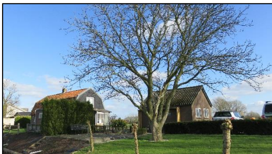
Foto 1. Te slopen gebouwen en te verwijderen vegetatie in het plangebied
