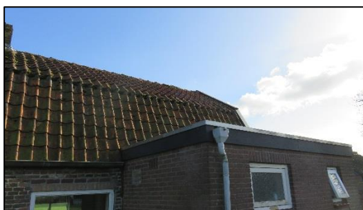
Foto 10. Dak van de te slopen woning
