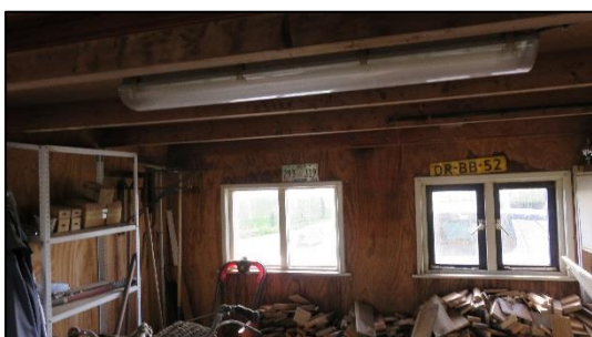
Foto 5. Binnenkant te slopen schuur
