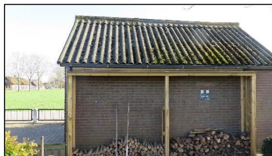
Foto 4. Noordzijde te slopen schuur
