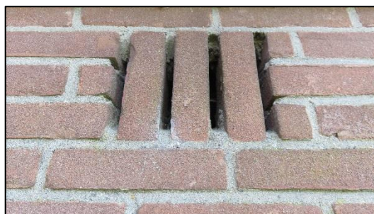
Foto 12. Lege spouwmuur met open stootvoegen in de te slopen woning
