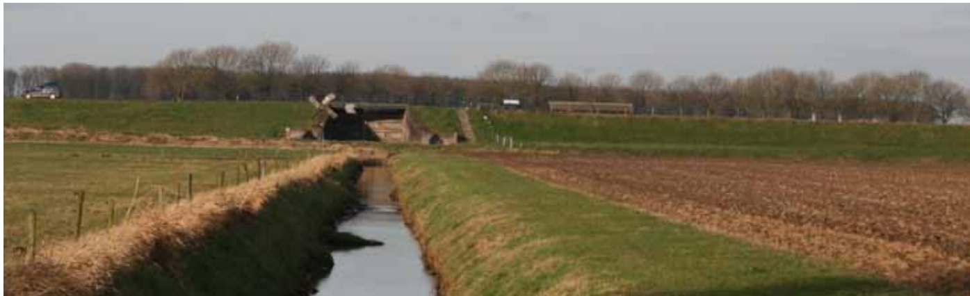
Papsluis aan de oostzijde
