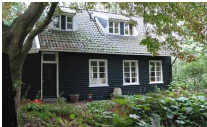
houten Verboden Kringenwetwoning
