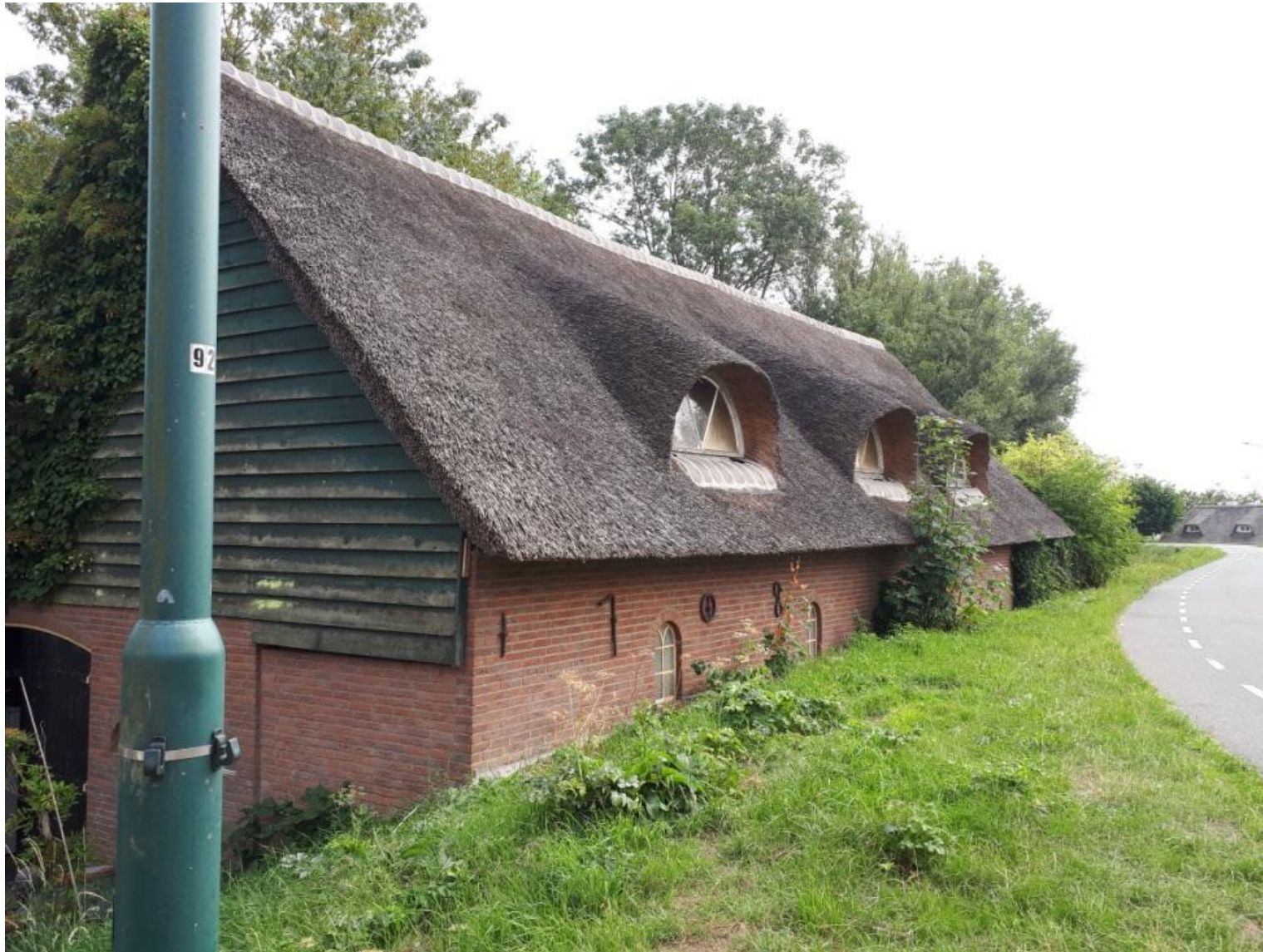
Figuur 16 - Noordelijke gevel (topgevel) en westelijke gevel, die naar de Hoge Maasdijk is gericht (foto: Cuijpers Advies, 2018)
