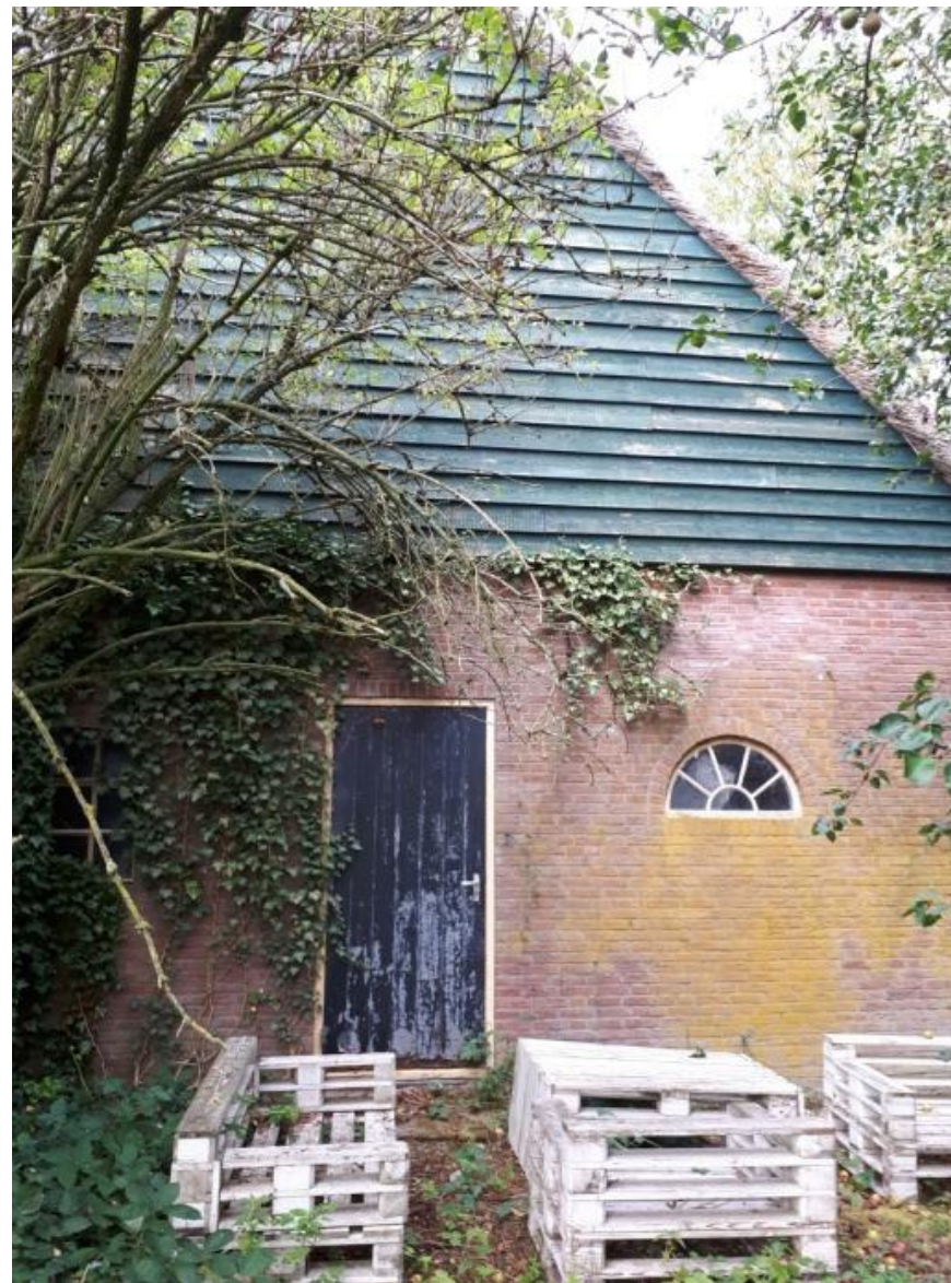
Figuur 15 - Zuidelijke gevel, topgevel met bovenzijde van gepotdekseld hout (foto: Cuijpers Advies, 2018)
