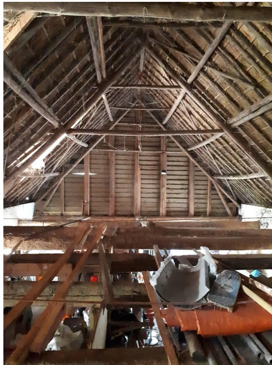
Figuur 20 - Interieur schuur: de voormalige hooizolder; duidelijk zichtbaar zijn de spanten van rondhout en de sporenkap.
