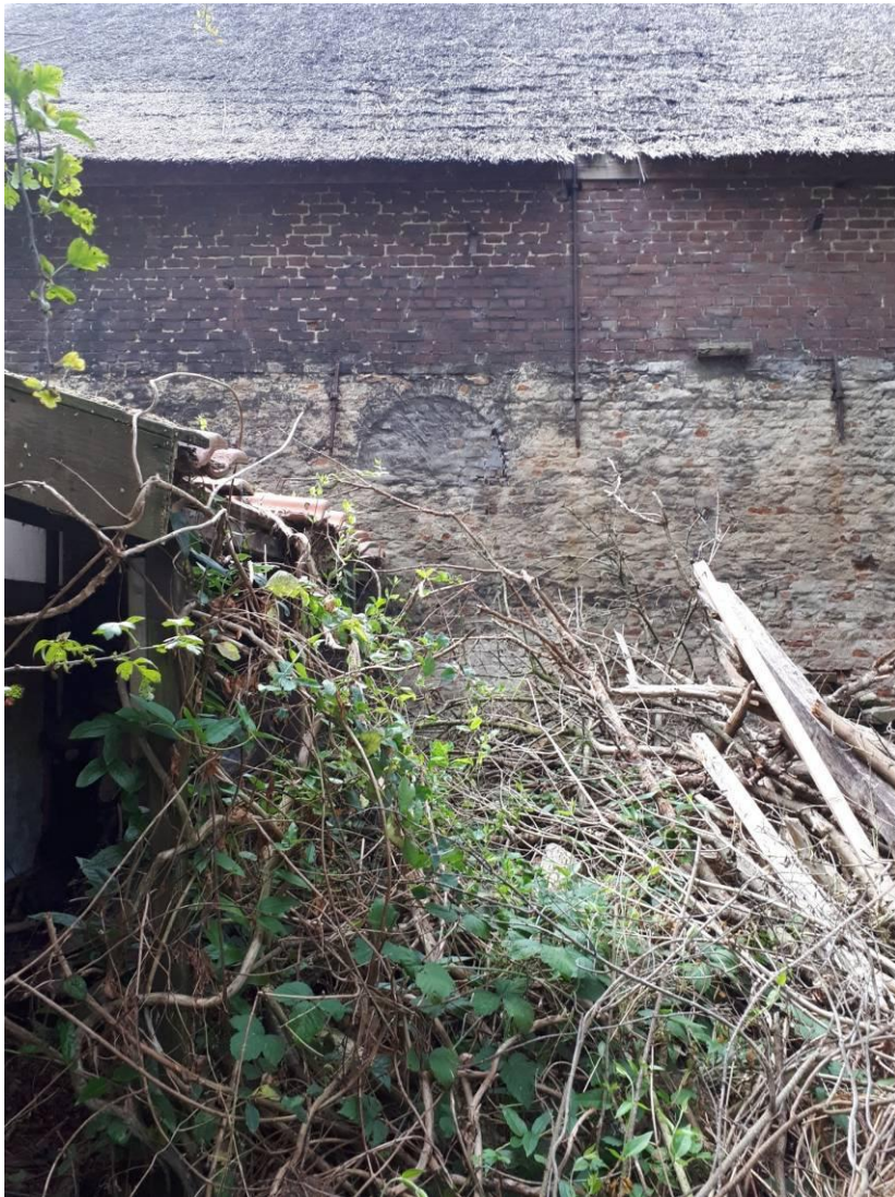
Figuur 17 - Oostelijke zijgevel (detail); de onderzijde van het metselwerk is vervaardigd van handvorm stenen; bouwsporen wijzen op een vroeger half rond venstertje en een kolom, waarschijnlijk als versterking ter plaatse van een spant.
