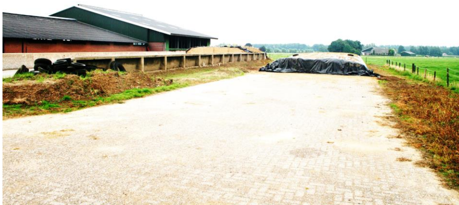
foto opstallen en kuilvloerplaten ten noorden van de Holthuiserstraat
