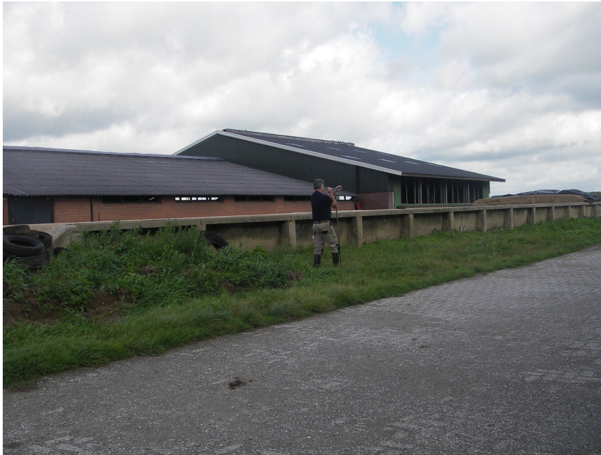
Figuur 2: Didam, Holthuiserstraat 20: Het plangebied gezien vanuit het zuidoosten, tijdens het plaatsen van boring 6.
