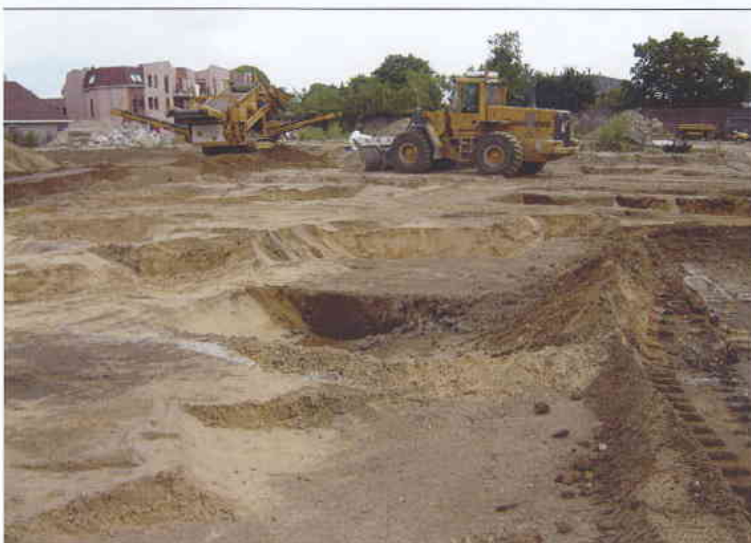
Situatie na ontgravingswerkzaamheden
