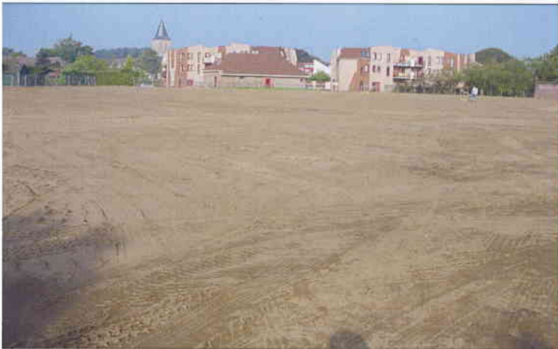
Eindsituatie na aanvulling van de ontgravingsput Vak A, B, C, D, D1 en D2
