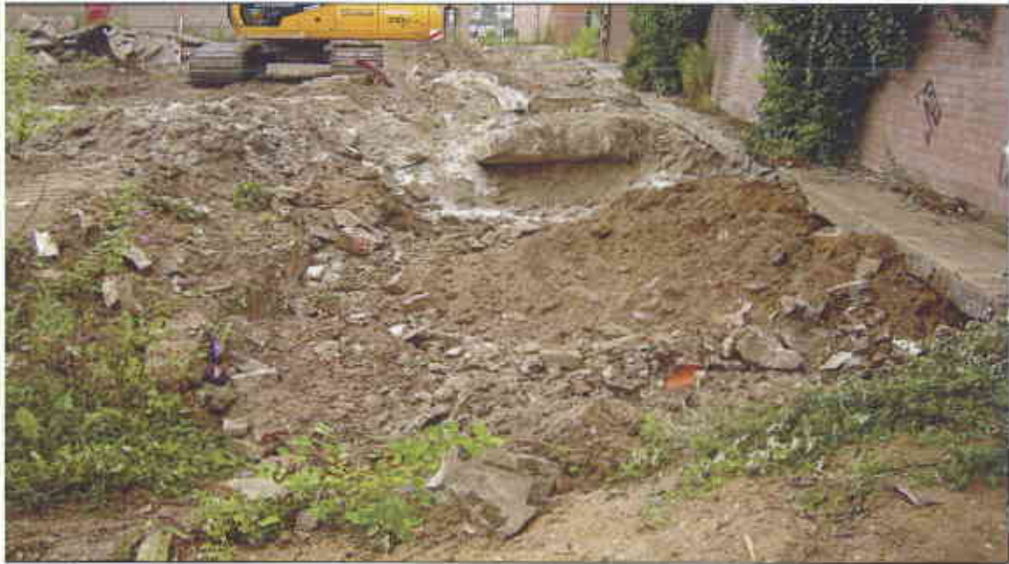
Volgestorte kelder met bodemvreemd materiaal
