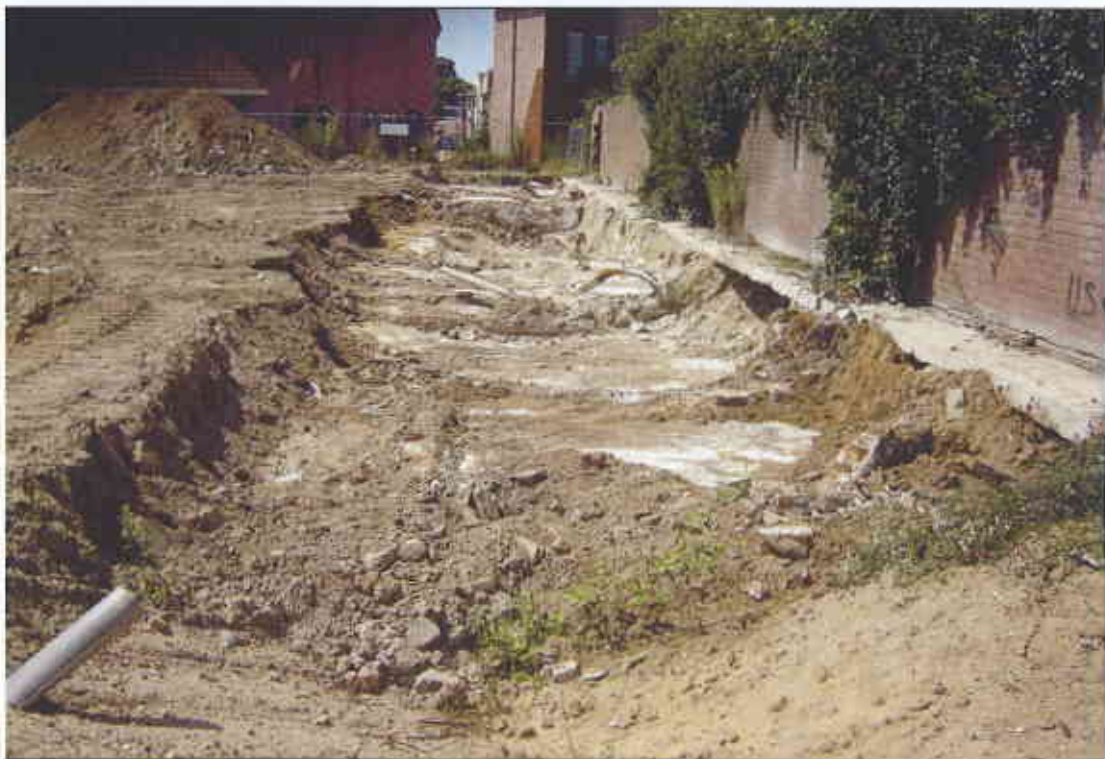
Zand/waterglas verharding ter plaatse van de voormalige kelders
