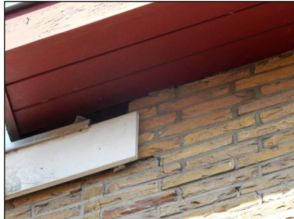
Figuur 14. Ruimte bij de betimmering en dakranden geven toegang tot de ruimte onder het dak.
