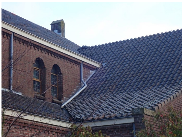
Foto 3: links, detail van het dak met kilgoten bij de zijbeuk
