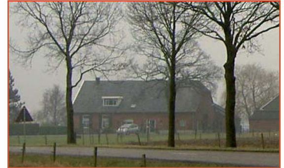
Hallehuis; lange zijgevel met groot dakvlak
