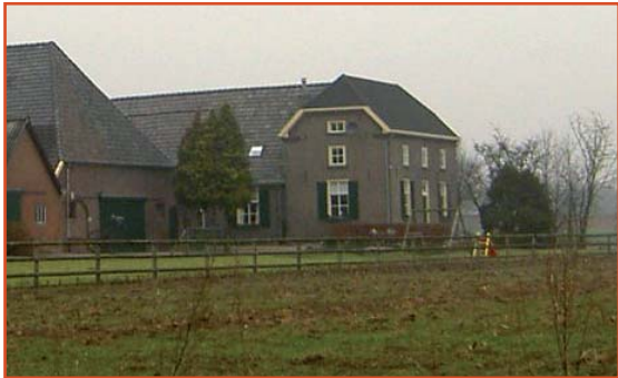
T-boerderij met donkere dakpannen
