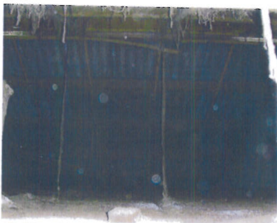
afgesloten ruimte tussen plafon en dakplaten
