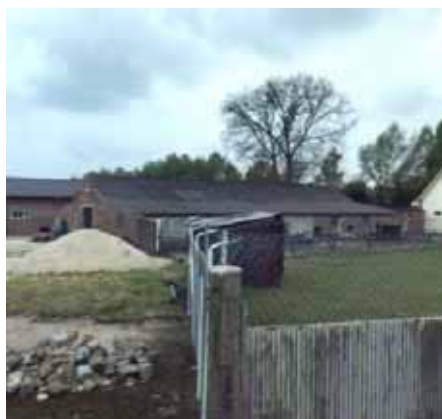
Te slopen schuur Holtpasweg 7 te Beek (287 m 2 )
