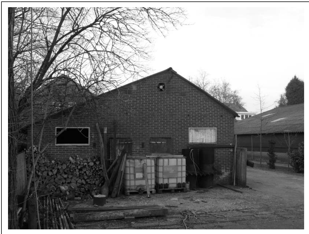
Foto 2. oostzijde deels te slopen schuur (oostelijke deel blijft gehandhaafd)
