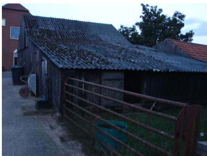
Eén van de schuren en op de achtergrond de woning
