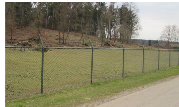
Het hekwerk in de huidige situatie
