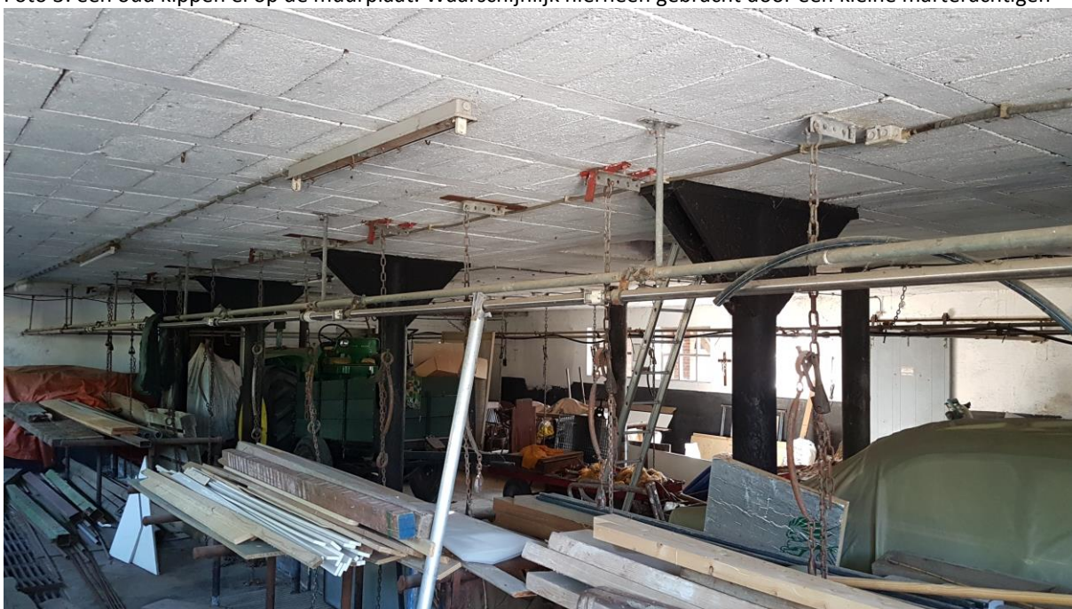
Foto 4: de begane grond van de aangebouwde schuur.
