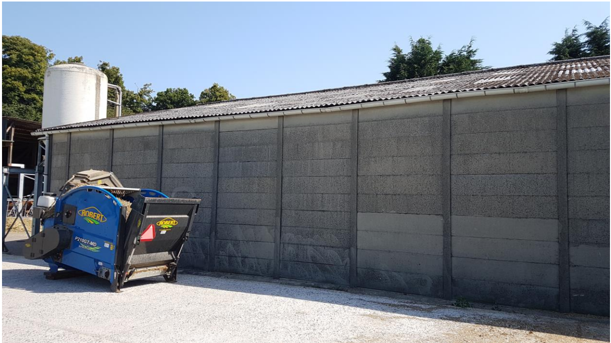
Foto 19: de nieuwe schuur is opgetrokken uit betonplaten en heeft een golfplaten dak.
