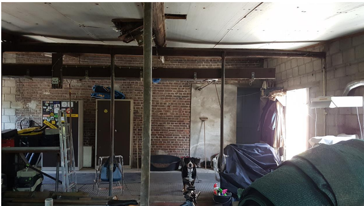
Foto 7: binnen de nieuwere aangebouwde schuur. Deze wordt voornamelijk gebruikt voor de opslag van goederen en het stallen van fietsen en is in gebruik. Het golfplaten dak is na geïsoleerd met isolatieplaten.
