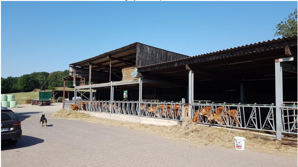
Foto 15: de nieuwe stal bestaat uit een metalen frame afgewerkt met golfplaten.
