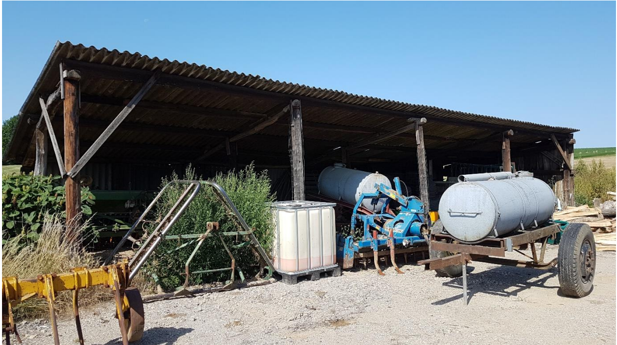
Foto 25: de kapschuur op de westelijke hoek van het perceel bestaat uit een houten frame afgedicht met golfplaten.
