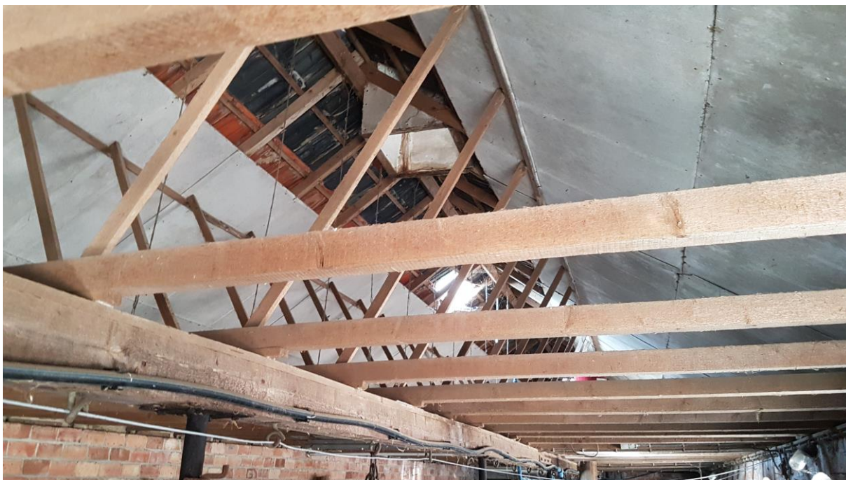
Foto 9: de eerste 1,5 meter van het dak is afgewerkt met platen. Hierdoor is er een ruimte waartussen vogels kunnen verblijven.
