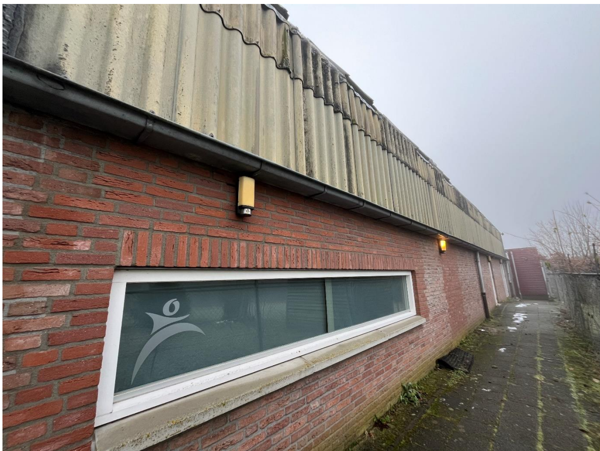
Foto 3: De westgevel van het dorpshuis met de metalen gevelbekleding.
