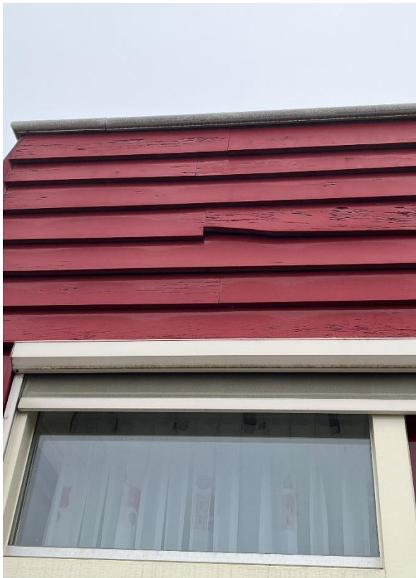
Foto 5: Impressie van de slecht aansluitende gepotdekselde planken aan de zuidwestzijde van het dorps huis.
