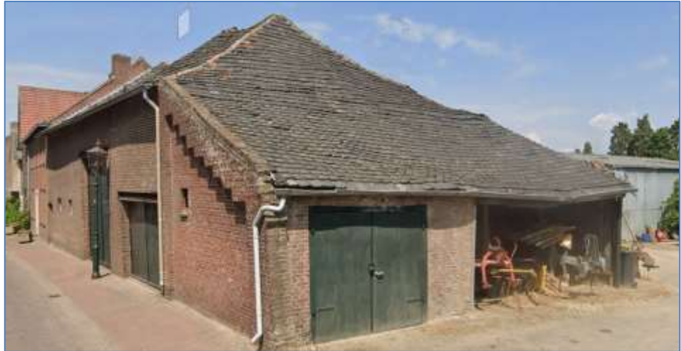
Oostzijde/ Oostgevel plangebied (de nog aanwezige schuur is inmiddels gesloopt)
