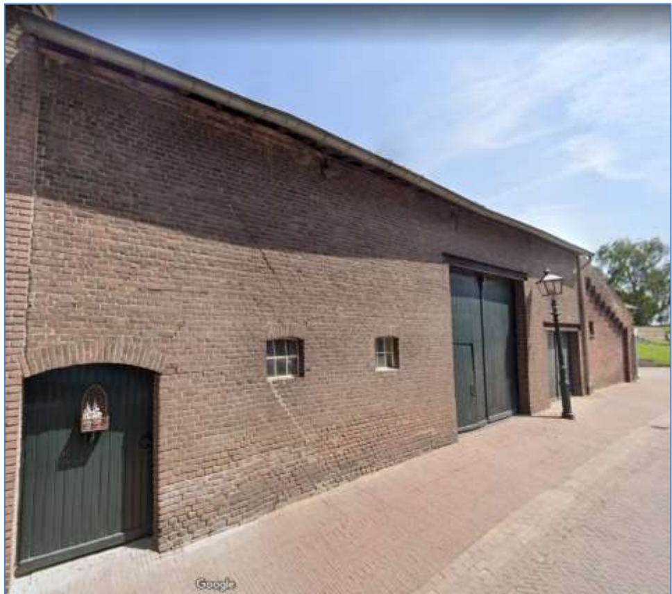
Zuidzijde/ bestaande voorgevel straatzijde plangebied (de nog aanwezige schuur is inmiddels gesloopt)
