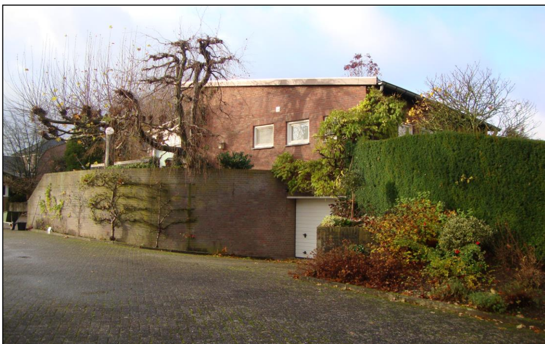
De achtergevel (zuidgevel) van de bedrijfswoning behorende bij het tuincentrum
