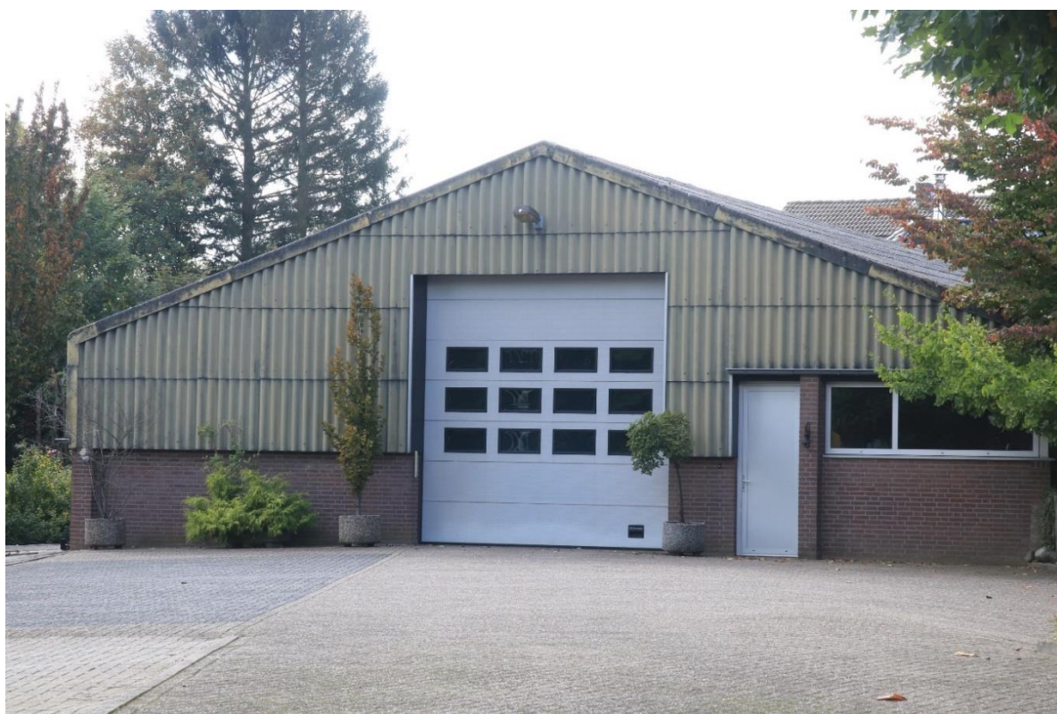
Foto 1: Te slopen opslagloods (onder andere bestaande uit asbestgolfplaten).
