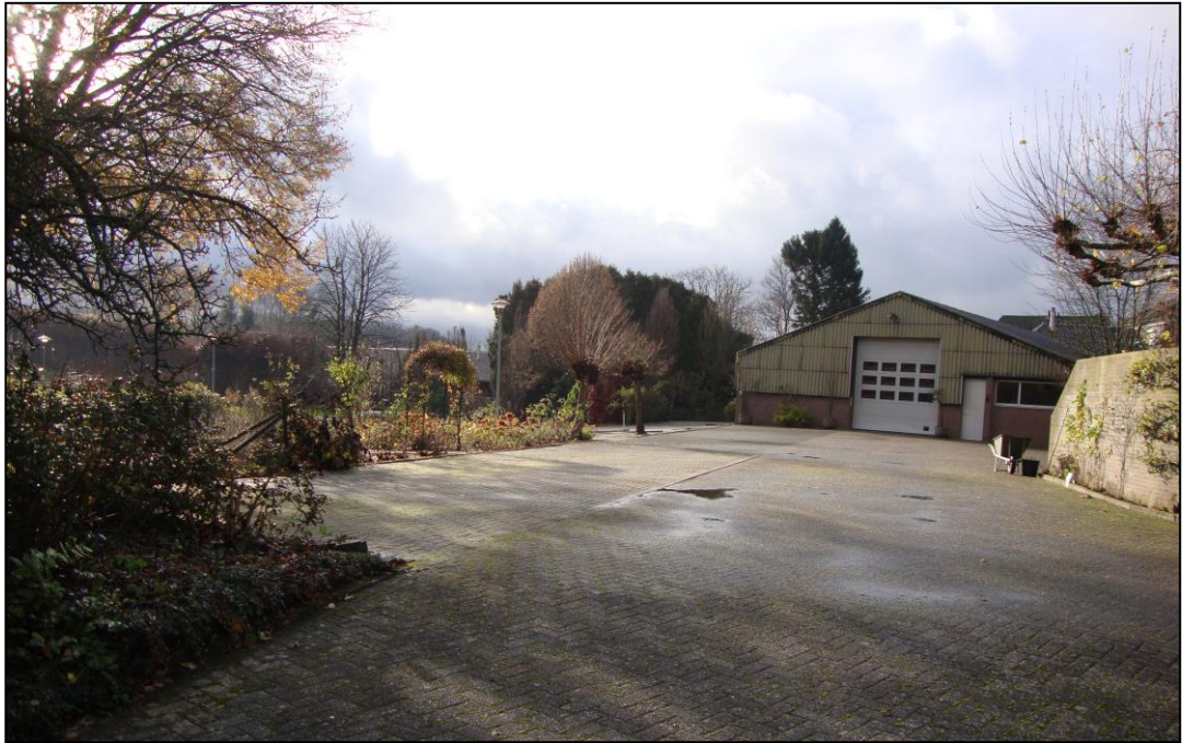
De bedrijfsloods die in het onderhavige plan wordt getransformeerd tot woning
