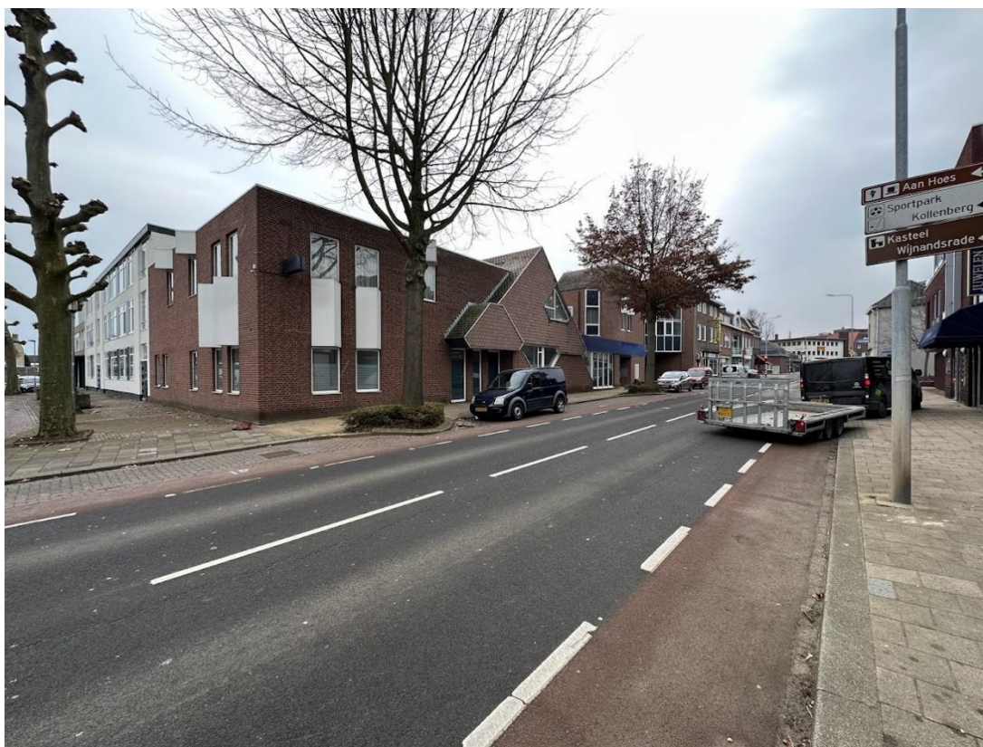
Figuur 3: Bestaand kantoorgebouw Stationstraat 171
