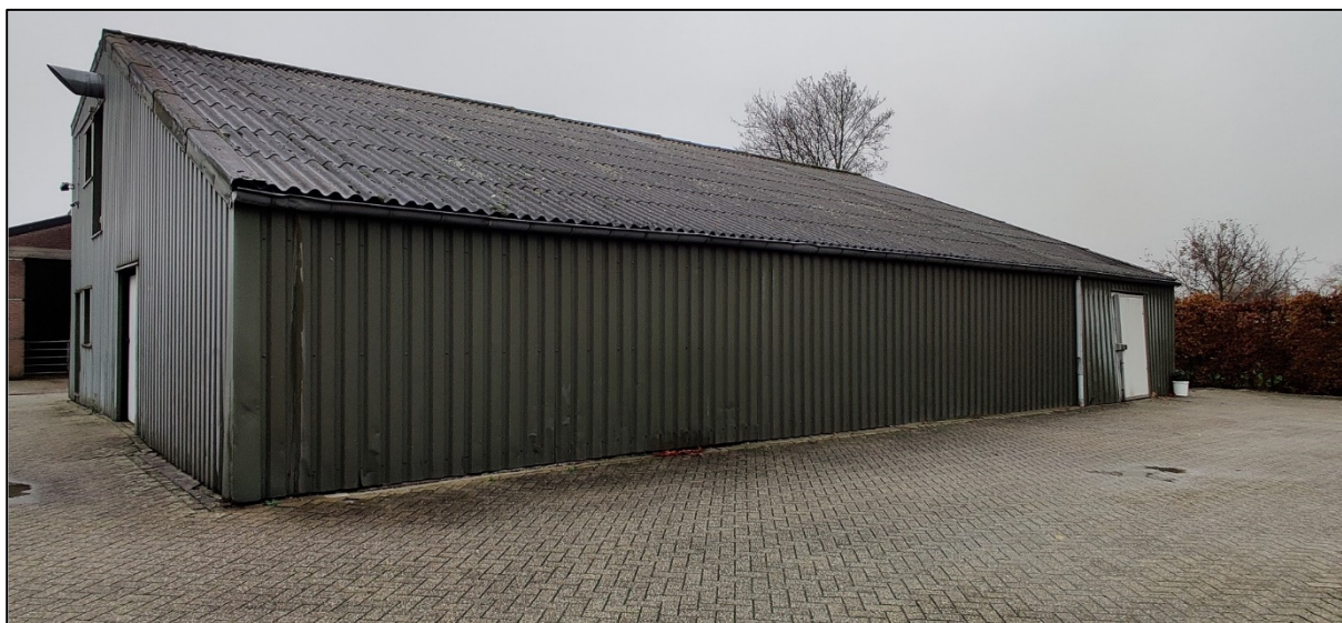
Dit gebouw is als opslagplaats voor materialen in gebruik.
