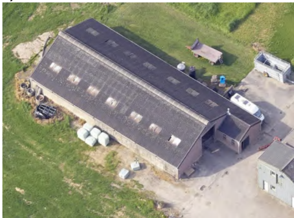
Foto 9 Schuur met asbestverdachte dakbedekking
