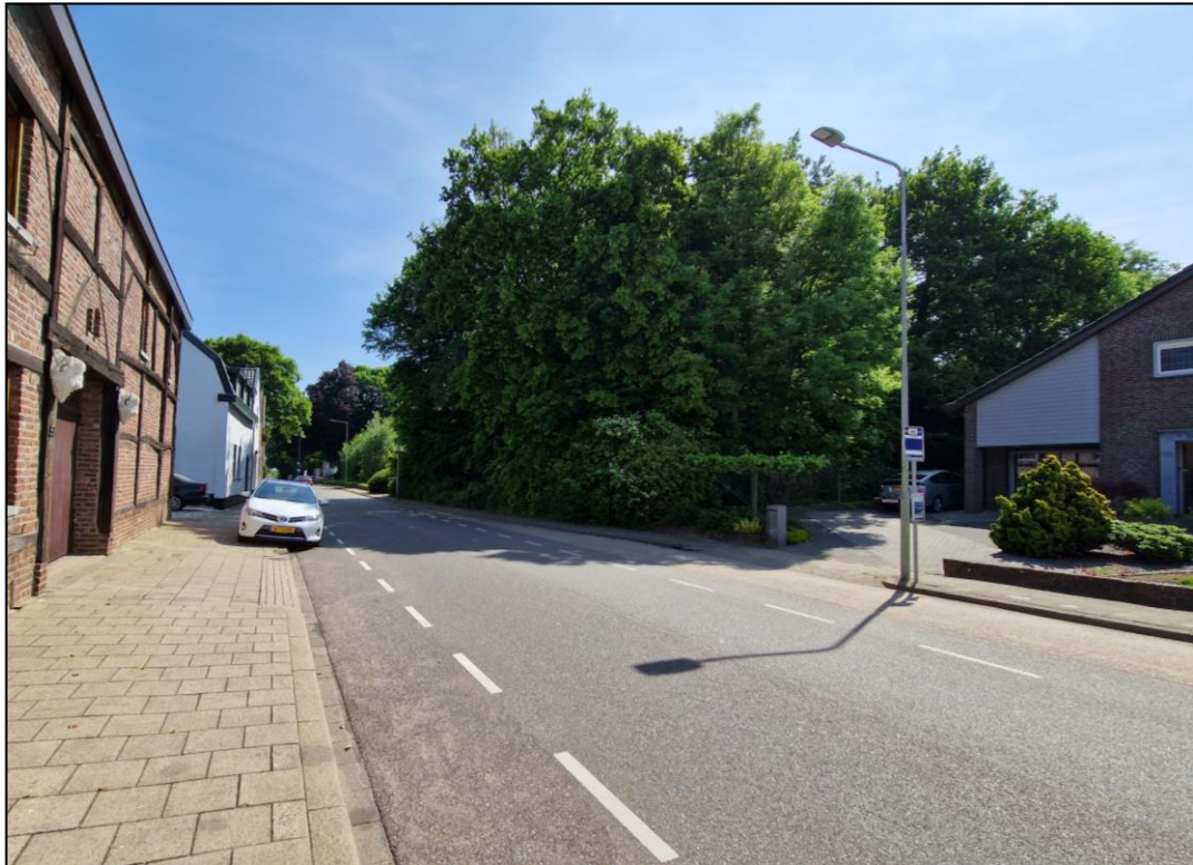
Woonperceel Op de Bies 64, het westelijke gedeelte van het plangebied
