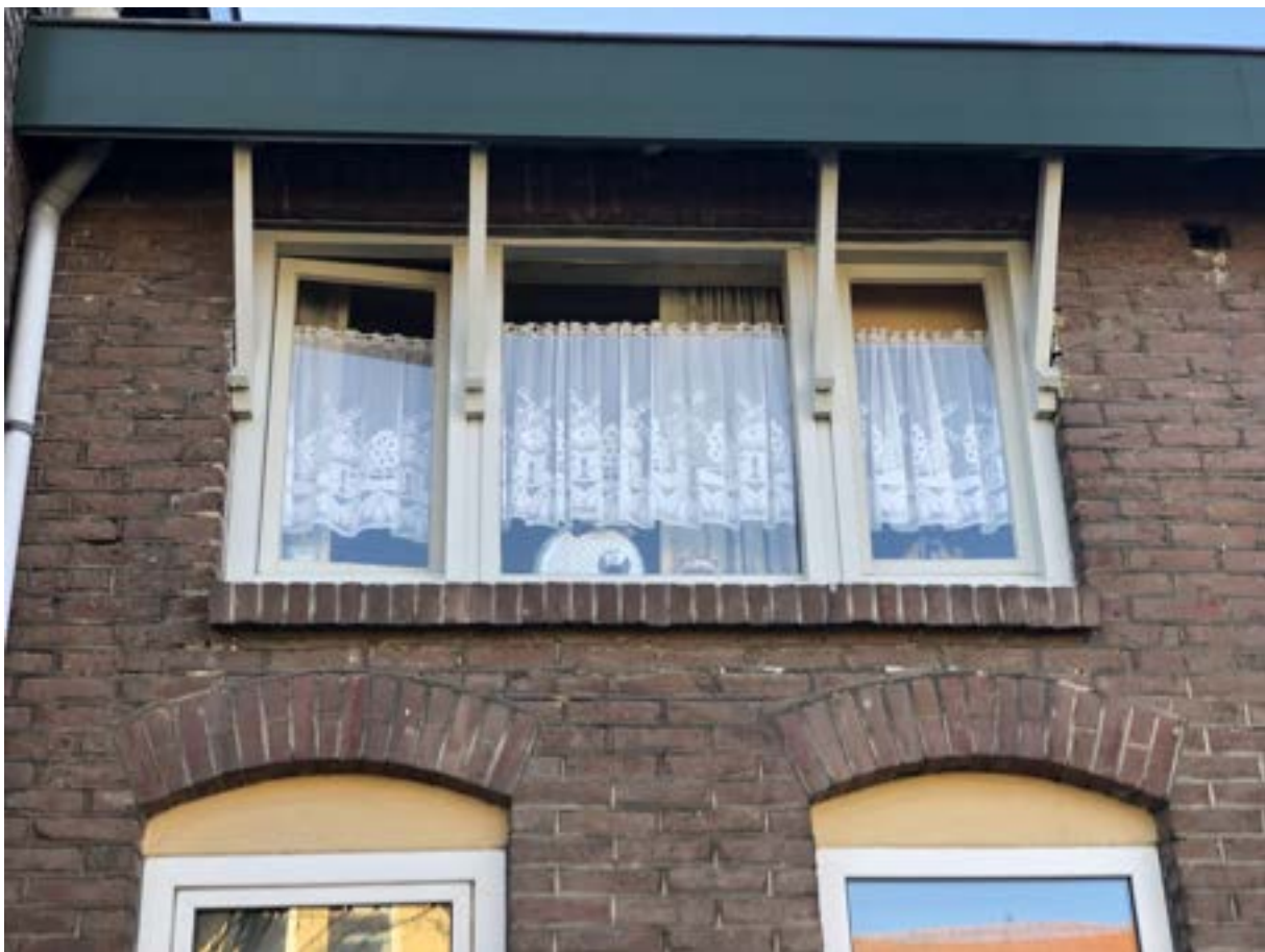
Oorspronkelijk houten kozijn op de verdieping
