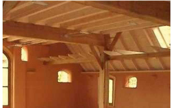
Aanbrengen binnenisolatie. Vergunning nodig.
