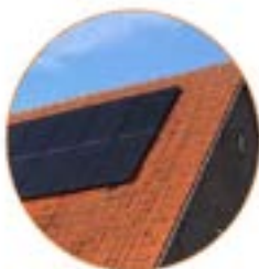
PV panelen op achterdakvlakken restauratie
