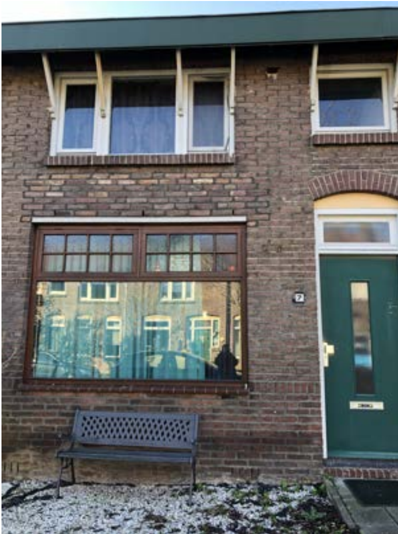
Twee smallere ramen zijn vervangen door één groot raam waarbij Ook de rollagen en gemetselde onderdorpels zijn verdwenen
