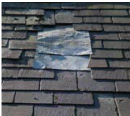
Herstel leiwerk conform bestaande toestand: vergunningvrij
