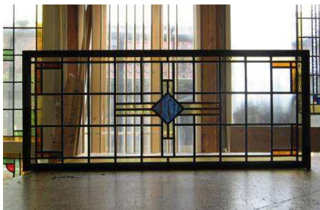
Glas-in-loodraam uitgenomen, hersteld en met dezelfde glassoort teruggeplaatst: vergunningvrij
