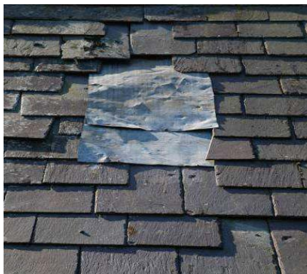
Herstel leiwerk conform bestaande toestand: vergunningvrij
