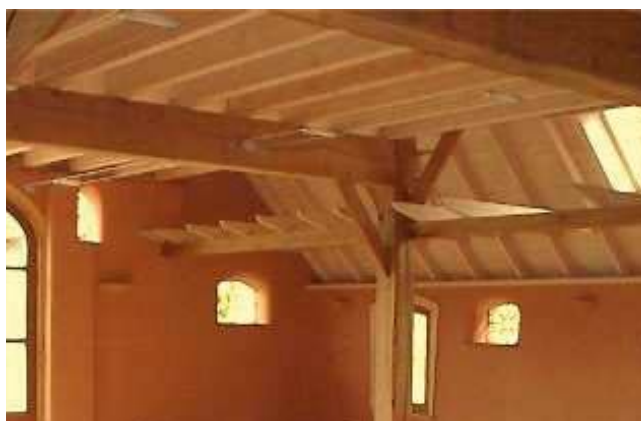
Aanbrengen binnenisolatie. Vergunning nodig.
