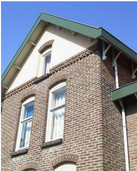
Bestaande topgevel met versieringen
