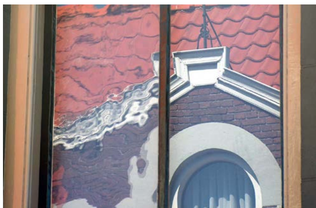
Vervanging van oorspronkelijk mondgeblazen glas (links) door modern glad floatglas (rechts), beide in een oud raam. Vergunning nodig.
