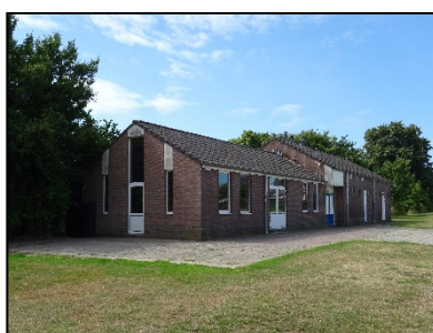
Figuur 4. Achter- en zijaanzicht clubgebouw, kijkrichting zuid.
