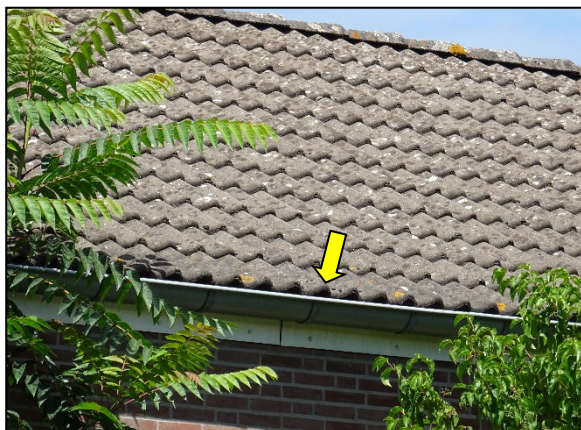
Figuur 18. Ruimte tussen dakpannen en dakgoot aan voorzijde clubgebouw, geschikt voor huismussen.
