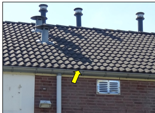
Figuur 19. Ruimte tussen dakpannen en dakgoot aan achterzijde clubgebouw, geschikt voor huismussen.
