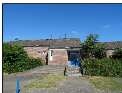
Figuur 3. Voorzijde clubgebouw, kijk-richting noordwest.
