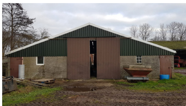
9. achterzijde beoogd te slopen stal
