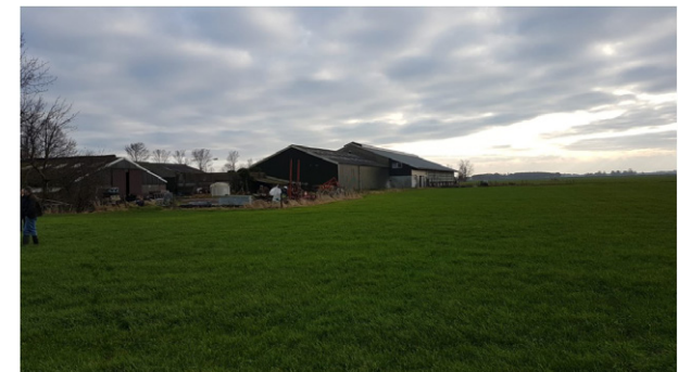
3. zicht langs westelijke zijgevel
