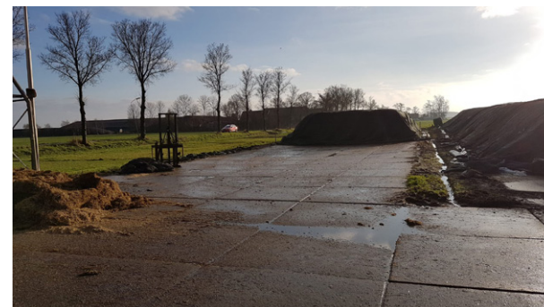
11. voeropslag op betonplaten aan de wegzijde
