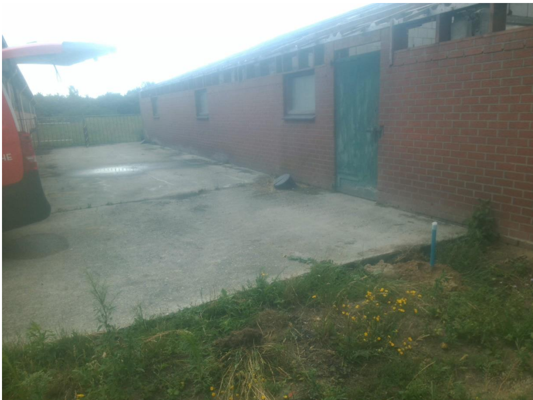
Foto ter plaatse van boring 04
