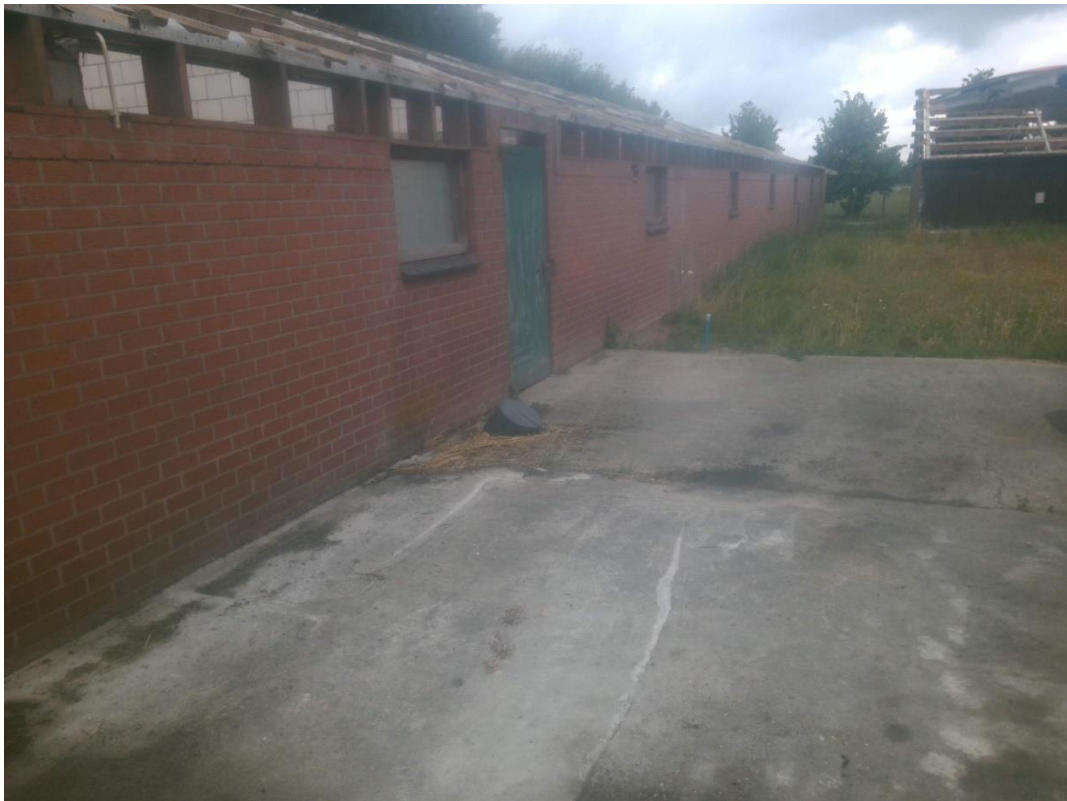
Foto ter plaatse van boring 04
