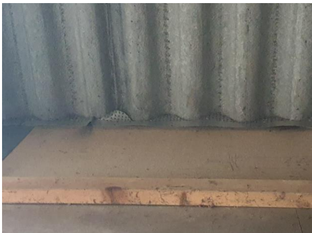
Figuur 4.3. Ruimte tussen golfplaten en gevels dichtgezet (foto links met rooster en foto rechts met vogelschroot).
