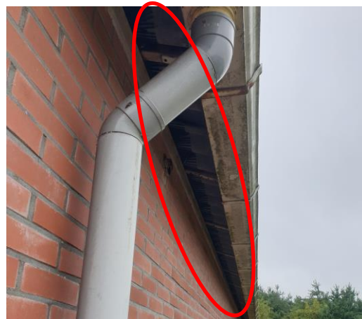
Figuur 4.3. Ruimte tussen golfplaten en gevels dichtgezet (foto links met rooster en foto rechts met vogelschroot).
