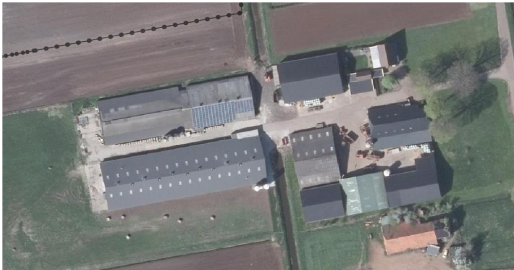
Luchtfoto Tussenklappen Westzijde 28/30
