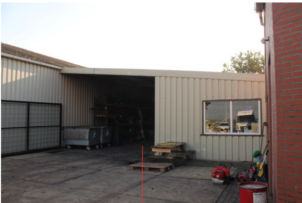
nieuwe aanbouwen leveren weinig samenhangend bebouwingsbeeld
