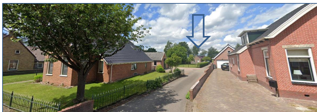
Fig. 2.4: Vanaf de Hoofdweg zicht op de bestaande woning
