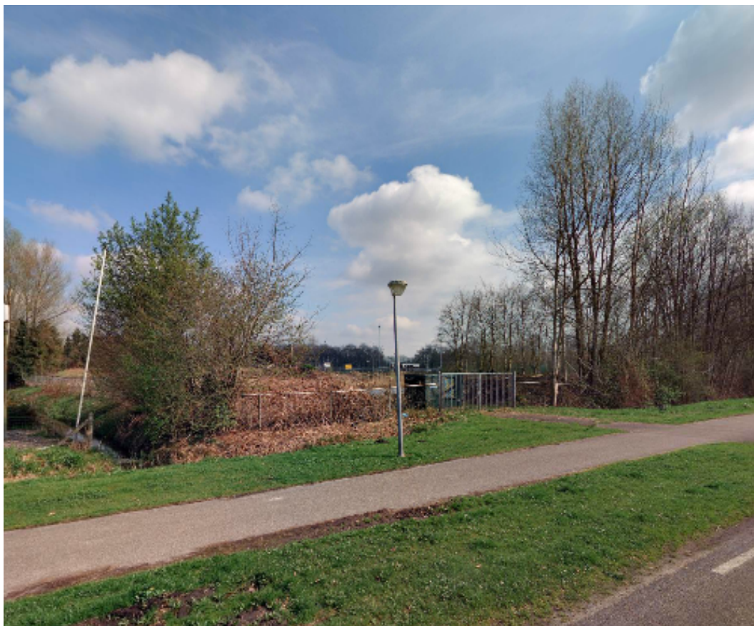
Figuur 4. Voorzijde locatie vanaf de Rijksweg Oost met trafostation Enexis.
