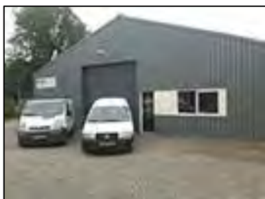
Figuur 6: Bedrijfshal Installatiebedrijf ReWo & De Jong
