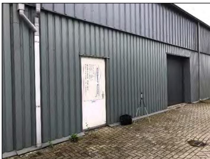
Figuur 7: Bedrijfshal Bouwbedrijf Bosman
