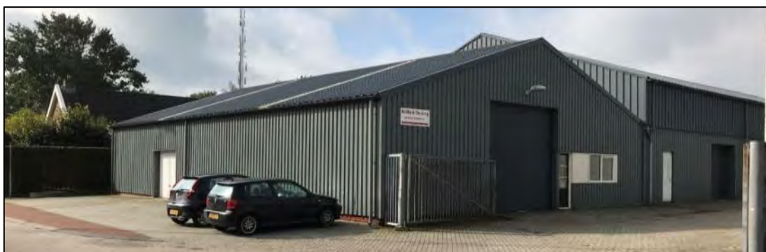
Figuur 5: Bedrijfshal Installatiebedrijf ReWo & De Jong
