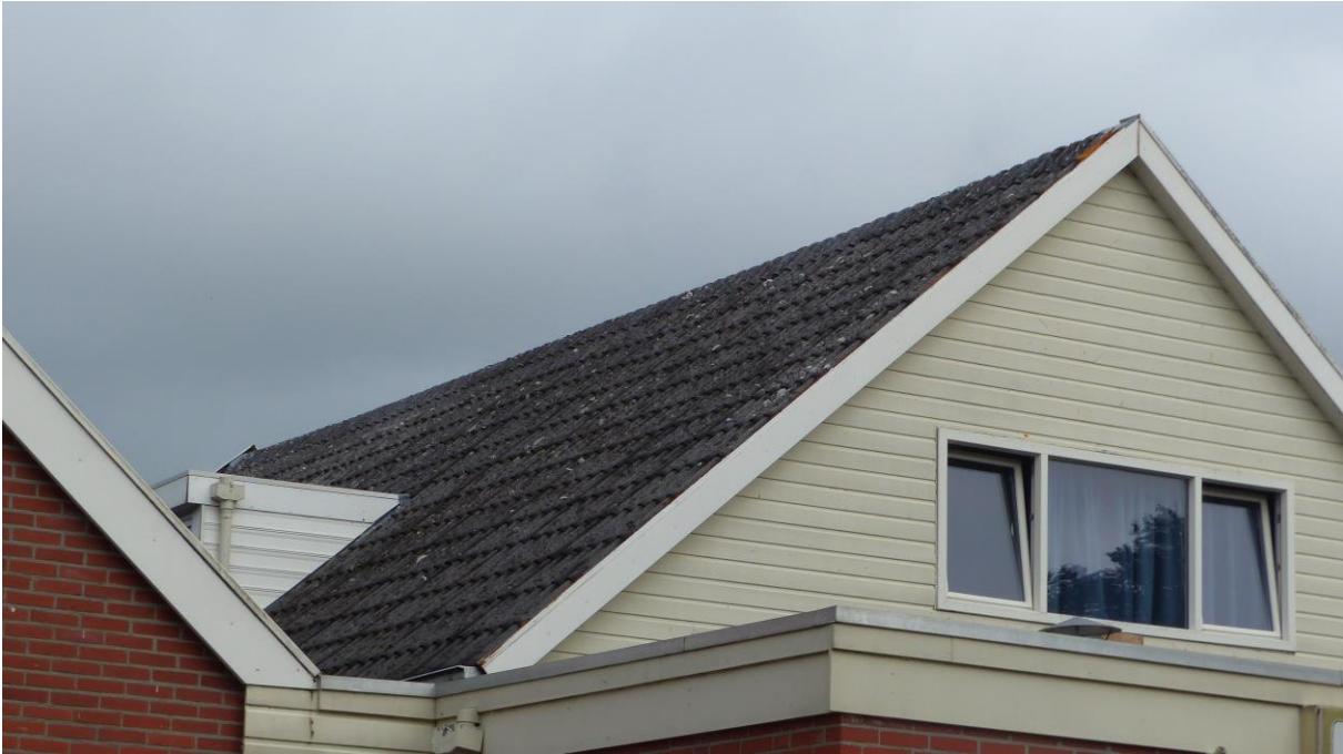
Figuur 4.3 Tussen de twee panden is het onwaarschijnlijk dat huismus tot broeden komt.
