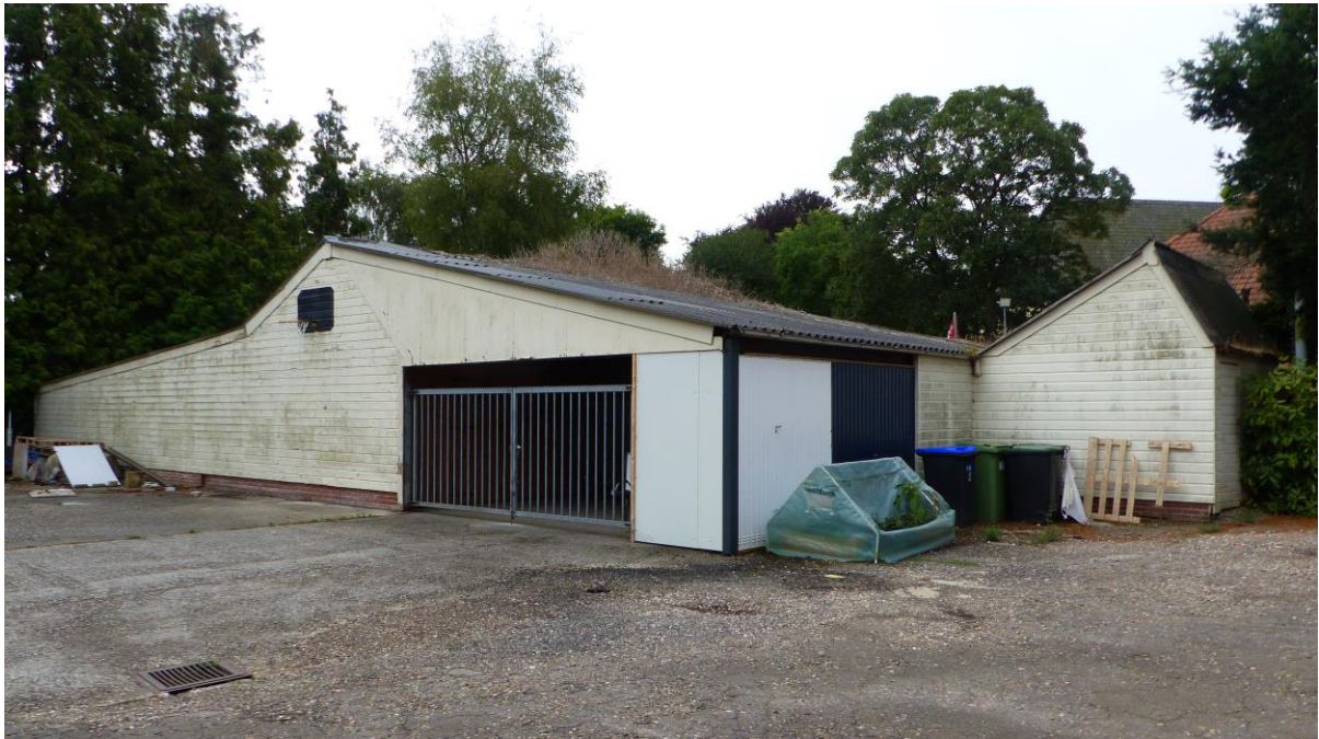
Figuur 1.5 De schuur aan de achterzijde.
