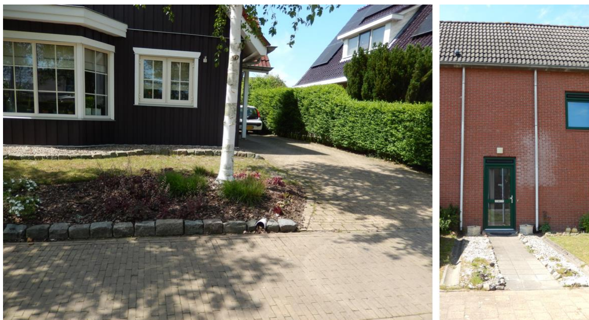
Figuur 16: Voorbeelden oppervlakkige afwatering dakwater (foto's J en L)
