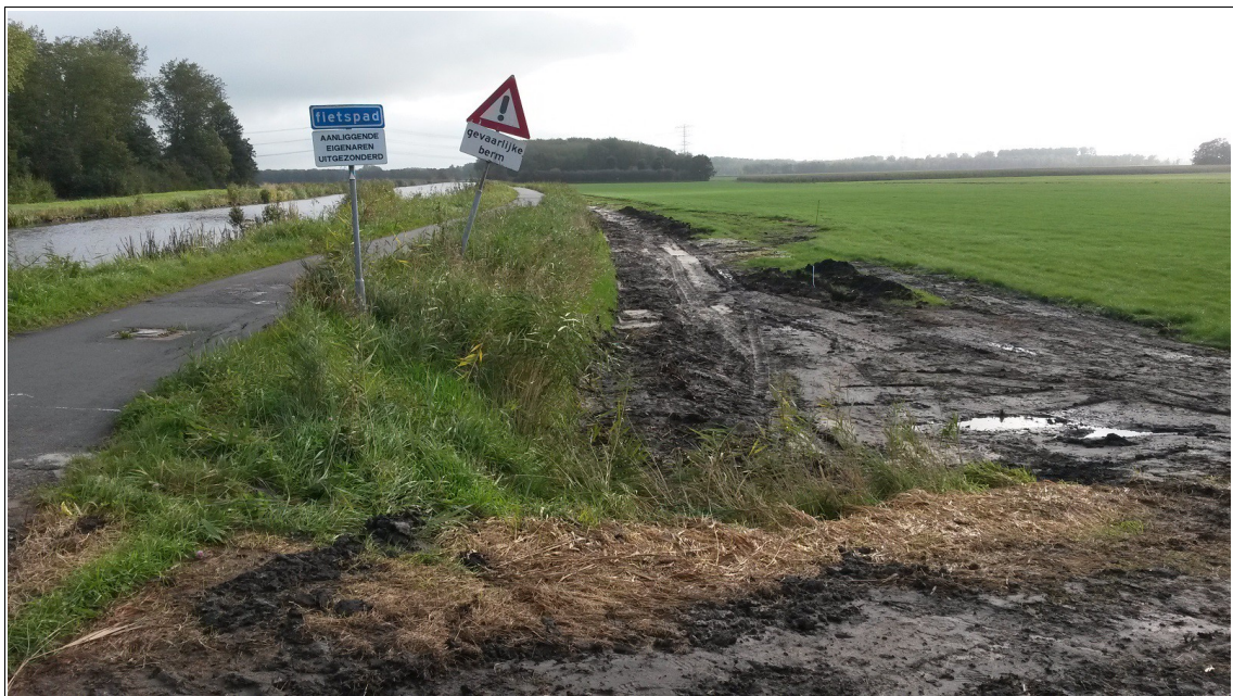
Figuur 2: Tjuchem, Afwateringskanaal: foto van het meest westelijke deel van het plangebied. Links op de foto het Afwateringskanaal met een fietspad over de langsegelegen dijk. Rechts daarvan is zichtbaar dat de bestaande sloot aan de voet van de dijk al is gedempt ten behoeve van de dijkverzwaring.
