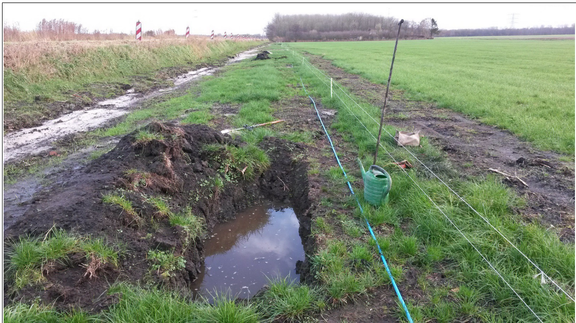
Figuur 6: Tjuchem, Afwateringskanaal: foto proefkuil in verband met het opsporen en vervangen van een oude dataverkeerskabel van KPN. Rechts van de kuil ligt op het maaiveld een nieuwe lichtblauwe dataverkeerskabel. Rechts daarvan wordt bij de gieter boring 40 uitgevoerd. In de stort van de kuil zijn meerdere scherven terpaardewerk gevonden uit de romeinse tijd. Ook lagen er een scherp roodbakkend geglaazuurd aardewerk uit de nieuwe tijd en enkele brokken baksteen en beton. De sloot aan de voet van de dijk was tijdens het onderzoek
